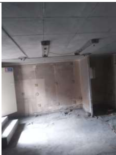
Фото 12. Внутреннее состояние Объекта оценки
