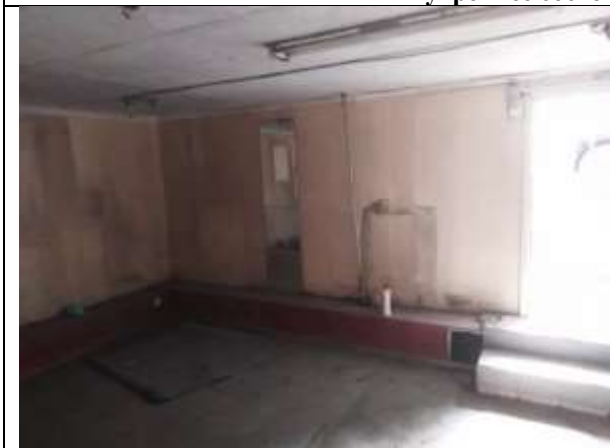
Фото 10. Внутреннее состояние Объекта оценки
