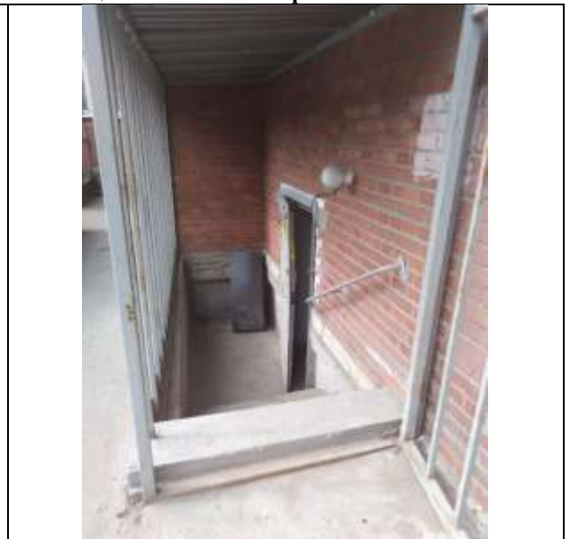
Фото 9. Отдельный вход Объекта оценки со двора
