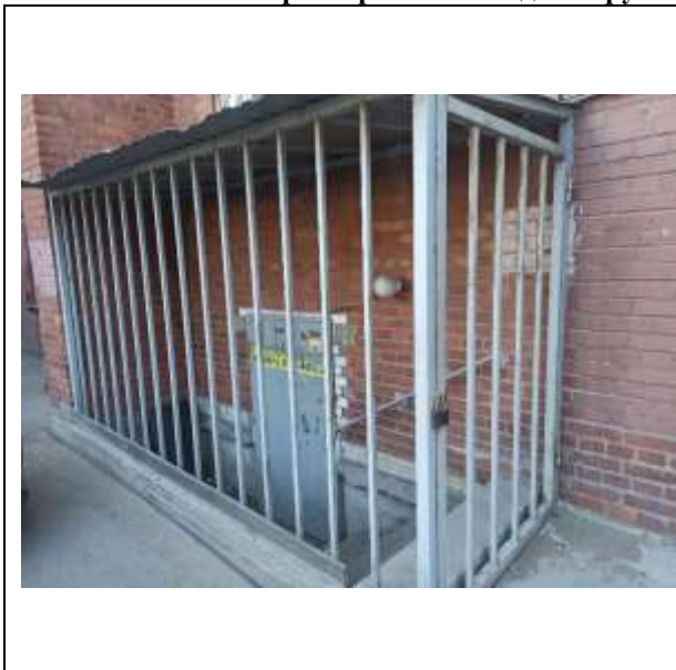
Фото 8. Отдельный вход Объекта оценки со двора
