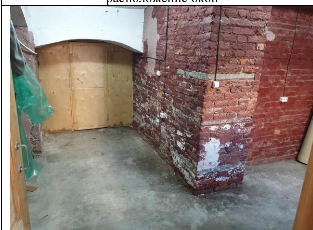
Фото № 9 – Внутреннее состояние помещения
