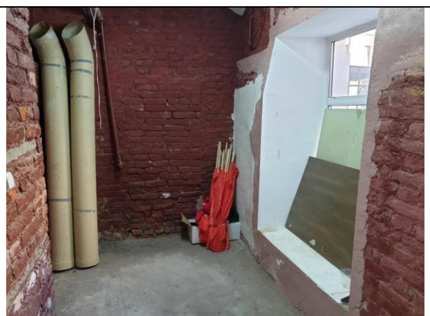
Фото № 10 – Внутреннее состояние помещения
