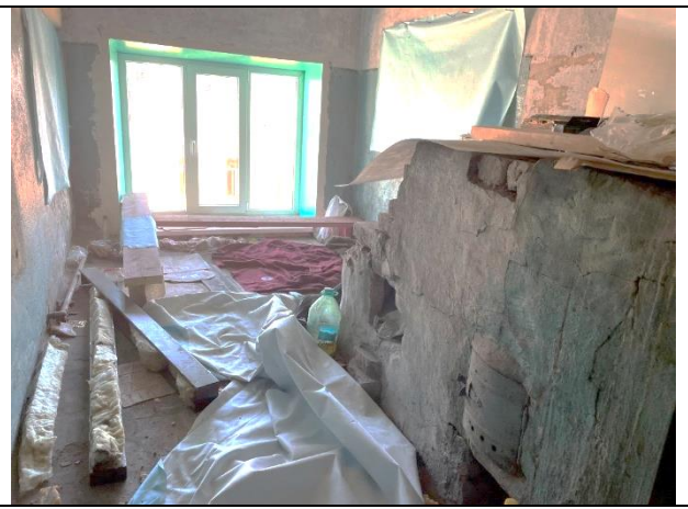
Фото 38. Типичное состояние Объекта оценки
