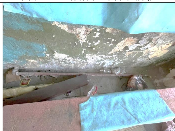
Фото 43. Типичное состояние Объекта оценки
