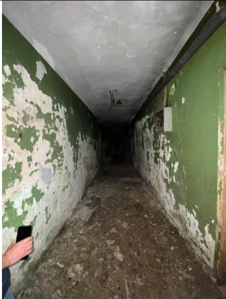
Фото № 19 – Внутреннее состояние помещения
