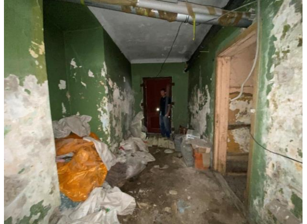
Фото № 16 – Внутреннее состояние помещения
