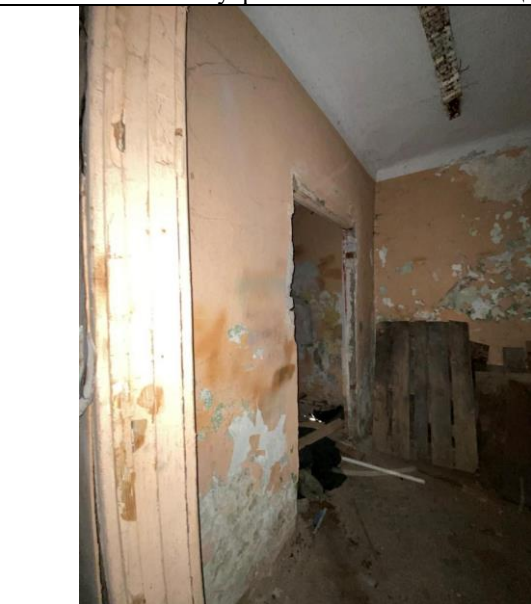
Фото № 17 – Внутреннее состояние помещения
