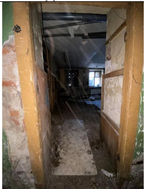
Фото № 22 – Внутреннее состояние помещения
