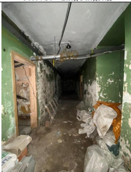
Фото № 11 – Внутреннее состояние помещения
