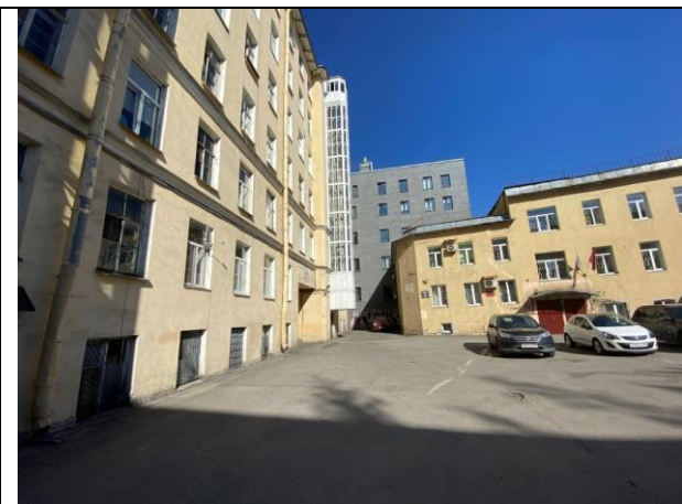
Фото № 7 – Окна объекта выходящие во второй двор
