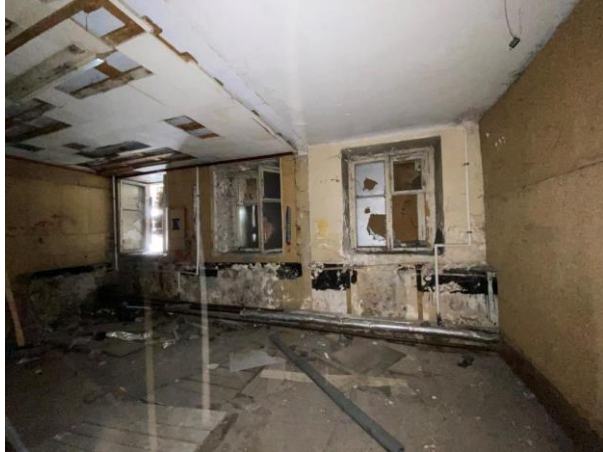
Фото № 15 – Внутреннее состояние помещения
