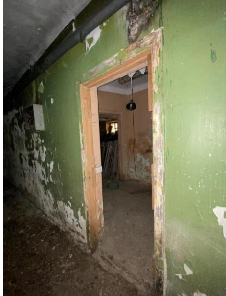
Фото № 20 – Внутреннее состояние помещения
