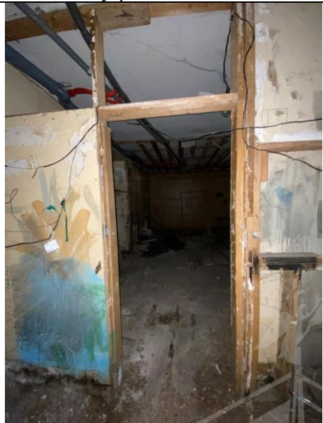
Фото № 24 – Внутреннее состояние помещения
