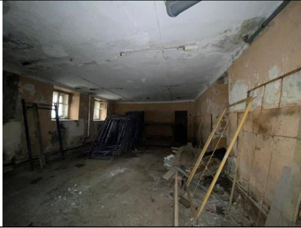
Фото № 13 – Внутреннее состояние помещения
