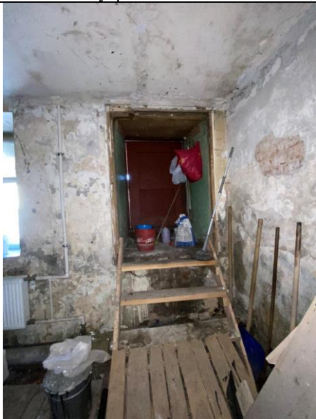
Фото № 23 – Внутреннее состояние помещения
