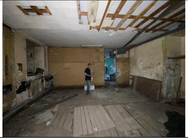
Фото № 14 – Внутреннее состояние помещения
