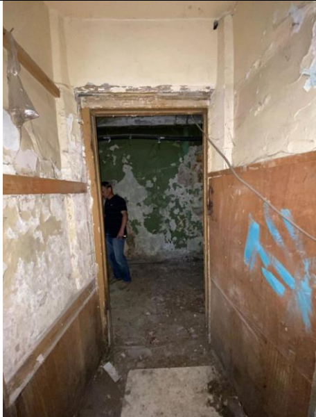
Фото № 25 – Внутреннее состояние помещения
