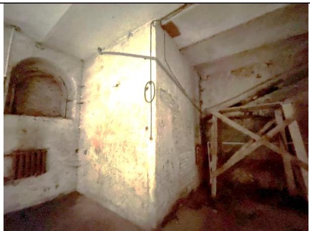
Фото 24. Типичное состояние Объекта оценки
