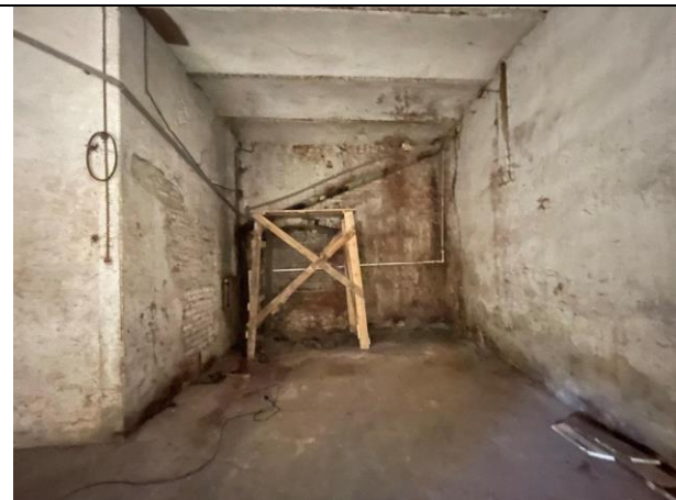
Фото 25. Типичное состояние Объекта оценки
