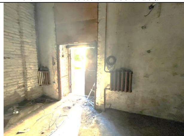
Фото 29. Типичное состояние Объекта оценки
