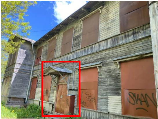
Фото 7.7. Вид на здание размещения Объекта оценки. Общий вход в подъезд.
