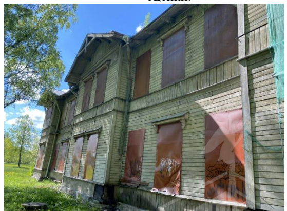
Фото 7.4. Вид на здание размещения Объекта оценки.
