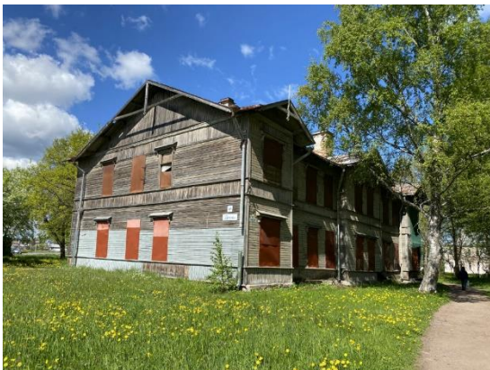
Фото 7.1. Вид на здание размещения Объекта оценки.
