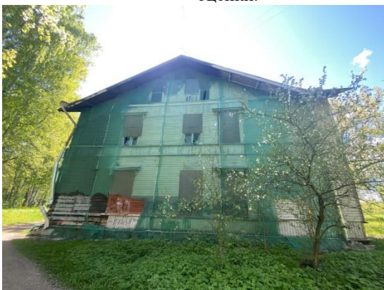
Фото 7.3. Вид на здание размещения Объекта оценки.
