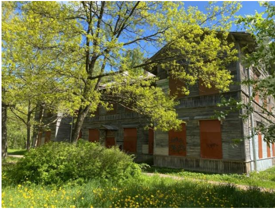
Фото 7.5. Вид на здание размещения Объекта оценки.
