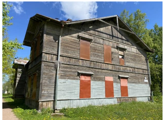
Фото 7.2. Вид на здание размещения Объекта оценки.
