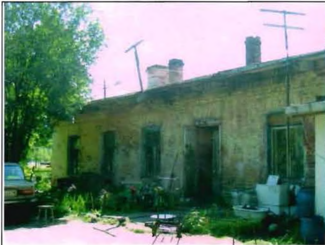
Фото 1. Северный фасад. Фрагмент.
