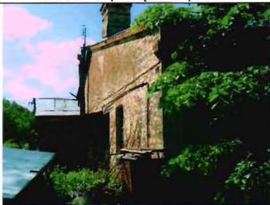
Фото 5. Восточный фасад. Общий вид.
