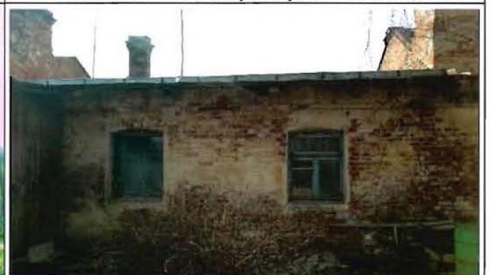
Фото 4. Северный фасад. Фрагмент.
