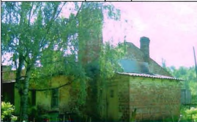
Фото 3. Северный фасад. Фрагмент.
