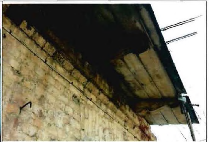
Фото 2. «Кобылки» северного фасада. Общий вид.
