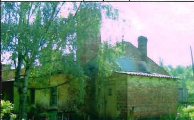
Фото 3. Северный фасад. Фрагмент.
