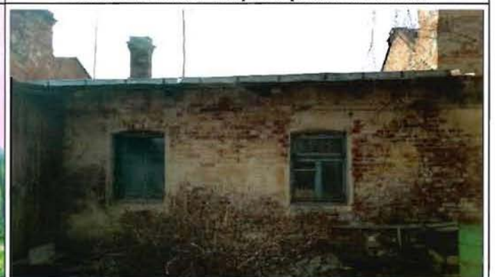
Фото 4. Северный фасад. Фрагмент.
