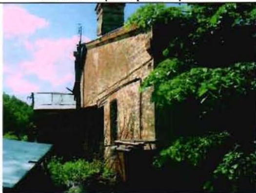
Фото 5. Восточный фасад. Общий вид.
