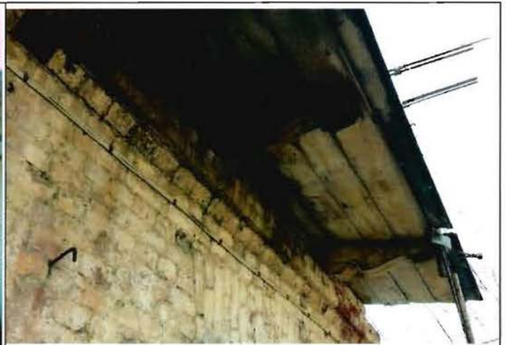
Фото 2. «Кобылки» северного фасада. Общий вид.
