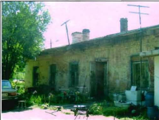
Фото 1. Северный фасад. Фрагмент.
