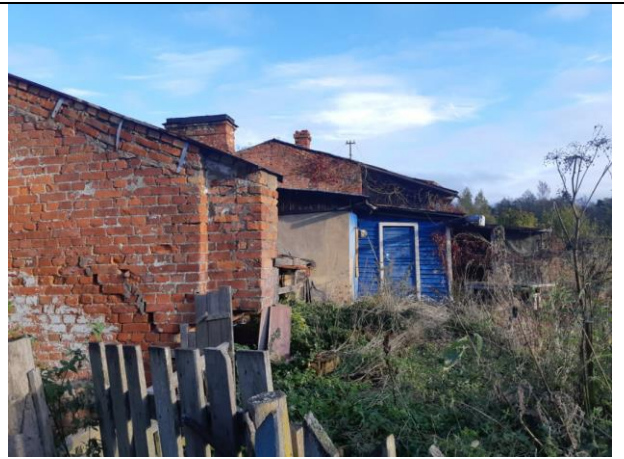
Фото 4. Вид на здание размещения Объекта оценки.
