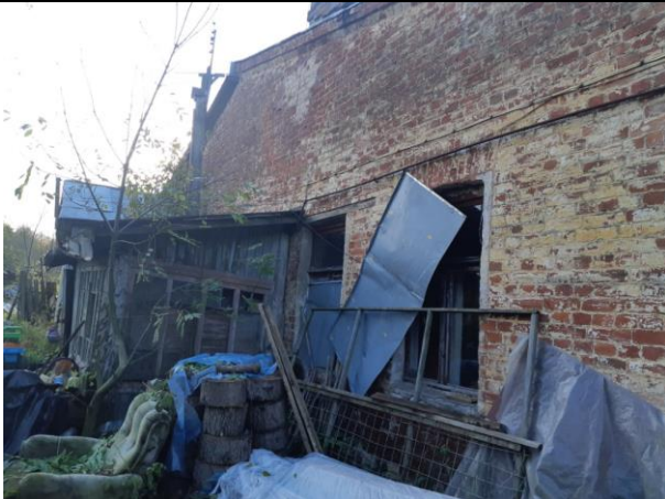
Фото 9. Вид на здание размещения Объекта оценки.
