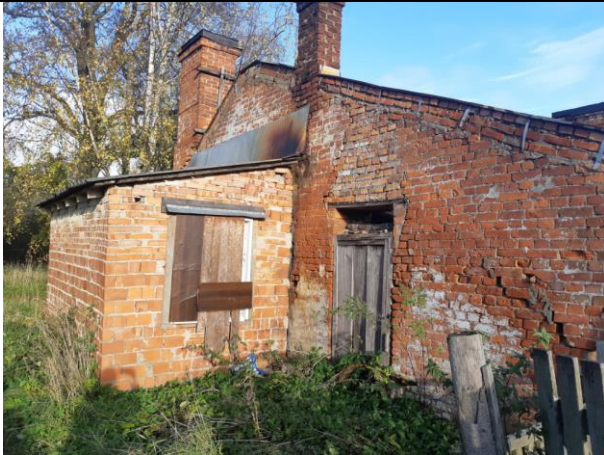
Фото 5. Вид на здание размещения Объекта оценки.
