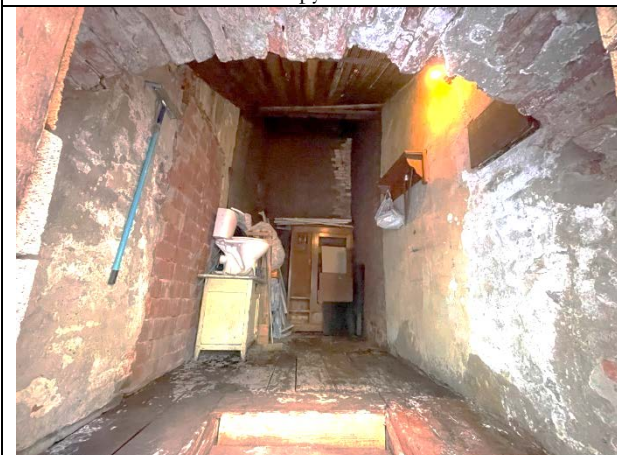
Фото 29. Типичное состояние Объекта оценки
