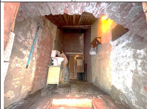
Фото 29. Типичное состояние Объекта оценки
