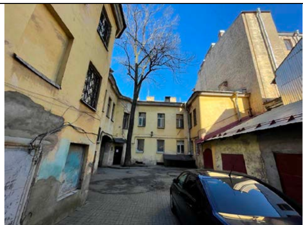
Фото 24. Внутри дворовая территория Объекта оценки
