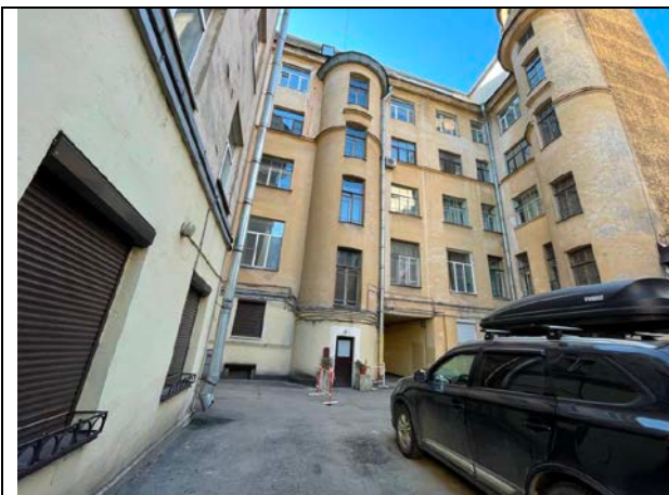
Фото 23 Внутри дворовая территория Объекта оценки
