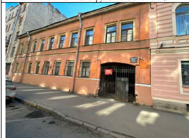
Фото 19. Вид здания Объекта оценки
