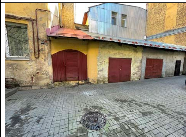
Фото 25 Внутри дворовая территория Объекта оценки
