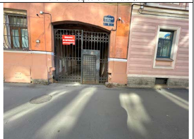
Фото 20. Проход через арку к Объекту оценки
