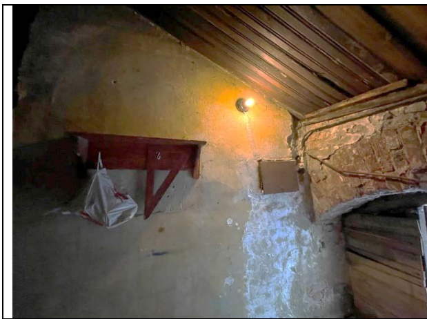
Фото 31. Типичное состояние Объекта оценки
