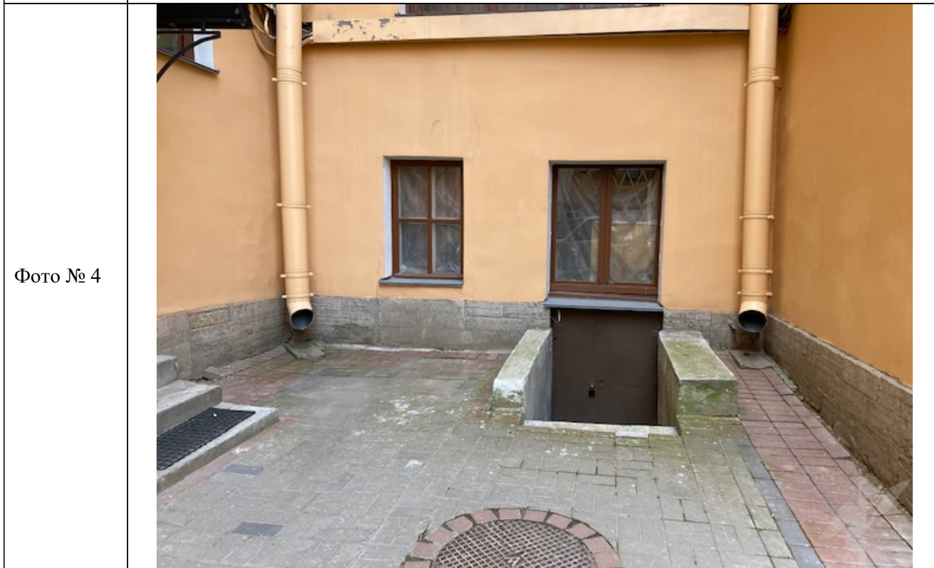
Описание: Вход в Объект, отдельный со двора.
