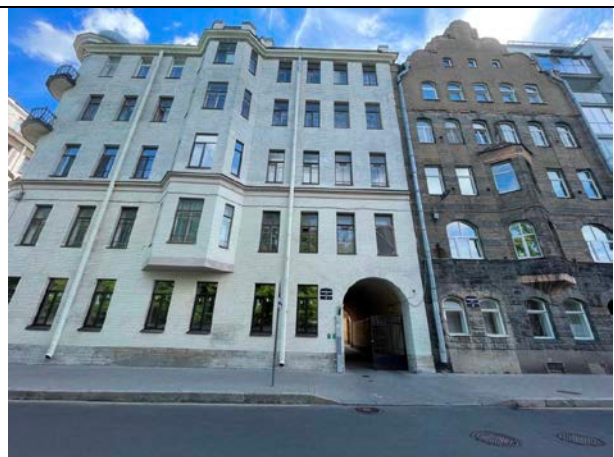
Фото 22. Вид здания расположения Объекта оценки
