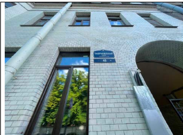
Фото 21. Адрес Объекта оценки
