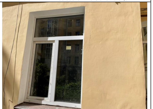
Фото 34. Окно Объекта оценки (со стороны двора)
