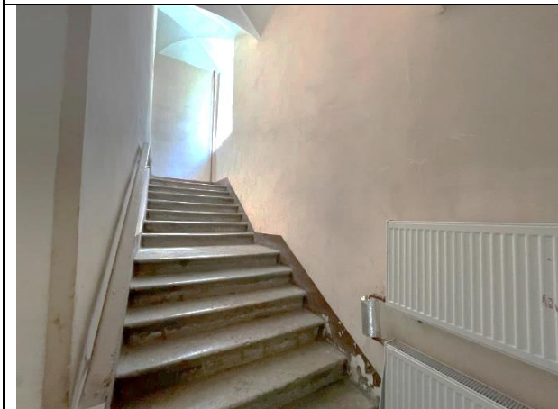
Фото 27. Лестница Объекта оценки
