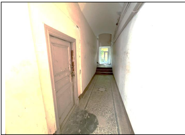
Фото 29. Вход в объект оценки
