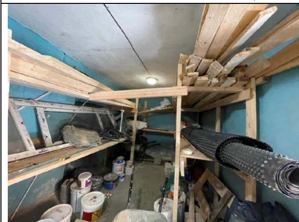
Фото 29. Типичное состояние Объекта оценки
