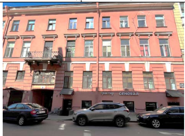
Фото 20. Вид здания расположения Объекта оценки
