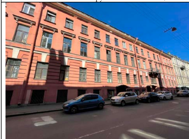
Фото 19. Вид здания расположения Объекта оценки
