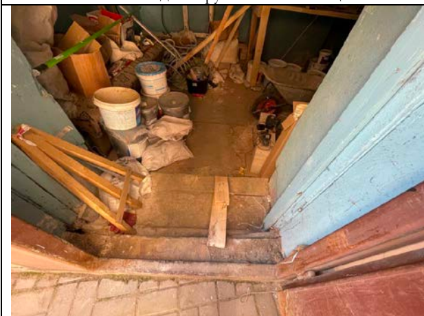
Фото 27. Типичное состояние Объекта оценки
