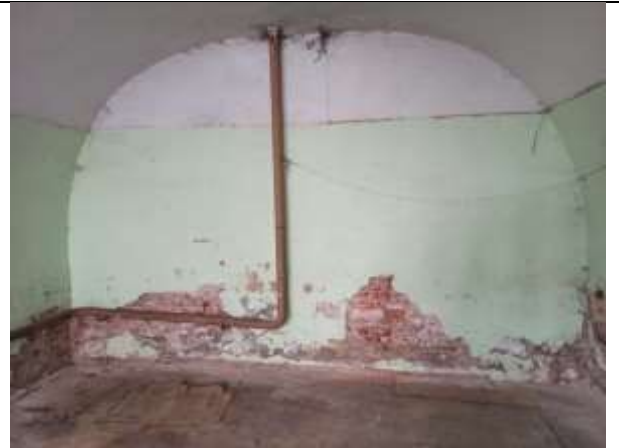
Фото 16. Внутреннее состояние Объекта оценки
