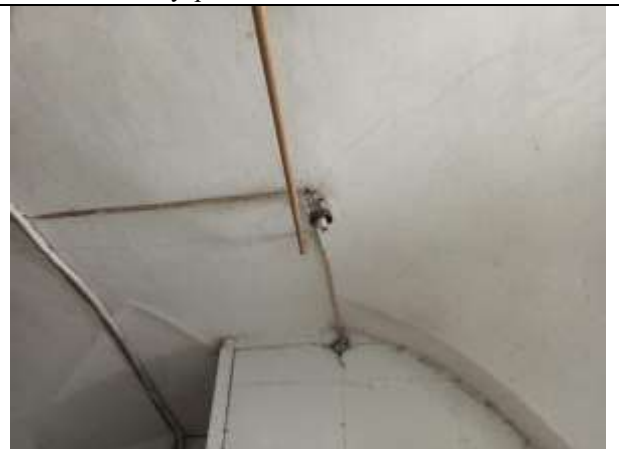
Фото 18. Внутреннее состояние Объекта оценки
