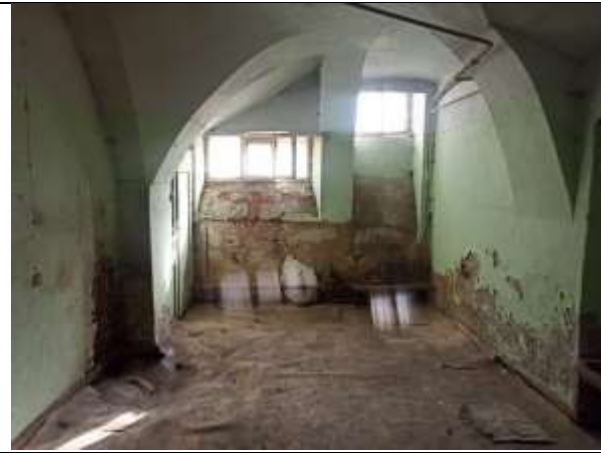
Фото 13. Внутреннее состояние Объекта оценки
