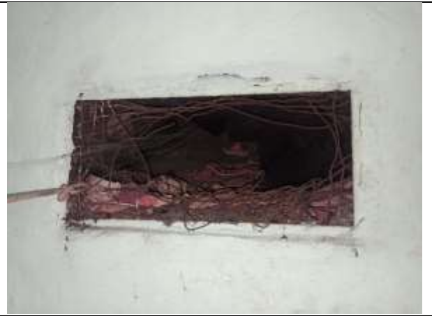
Фото 14. Внутреннее состояние Объекта оценки
