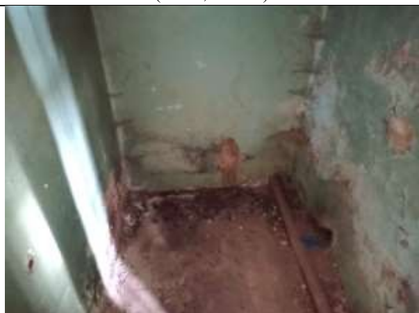
Фото 12. Внутреннее состояние Объекта оценки
