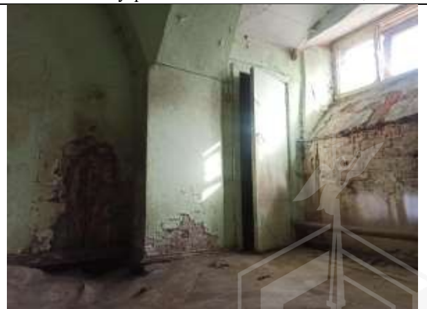
Фото 20. Внутреннее состояние Объекта оценки
