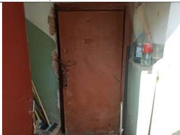
Фото 10. Внутреннее состояние Объекта оценки (ч.п. 1, 1 этаж)
