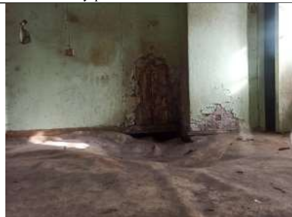
Фото 19. Внутреннее состояние Объекта оценки
