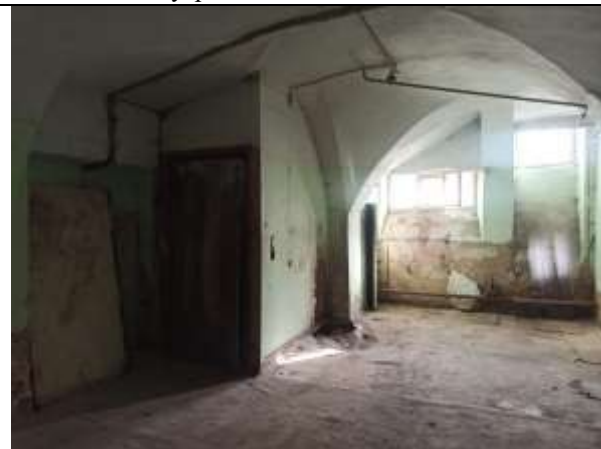
Фото 17. Внутреннее состояние Объекта оценки
