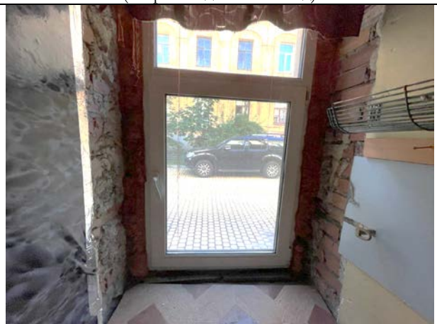
Фото 20. Вид окон Объекта оценки
