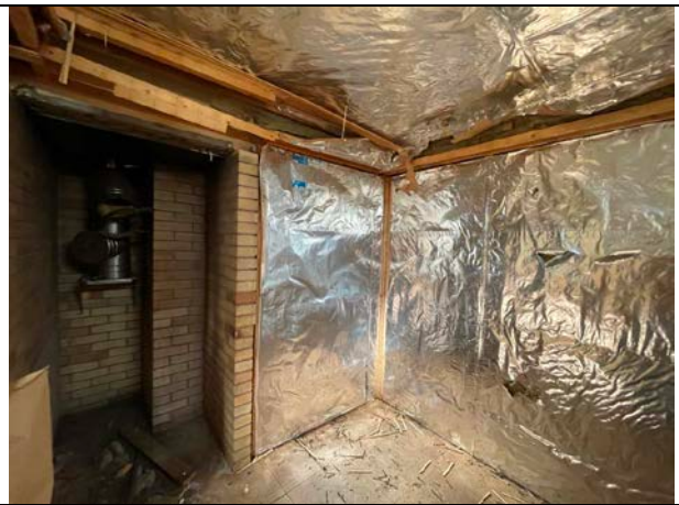
Фото 28. Типичное состояние Объекта оценки
