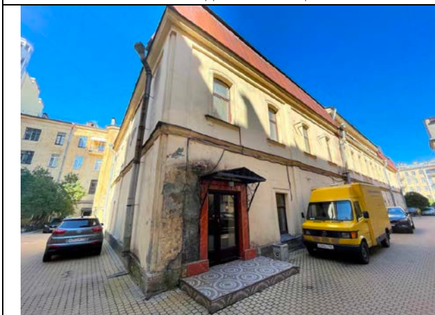
Фото 17. Входная группа Объекта оценки (первый отдельный вход)
