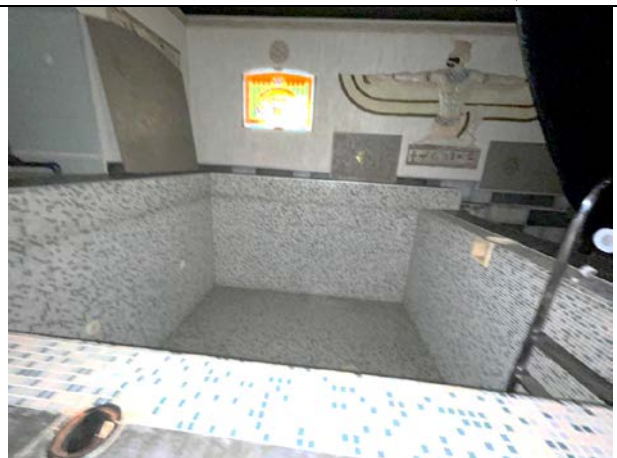
Фото 32. Типичное состояние Объекта оценки
