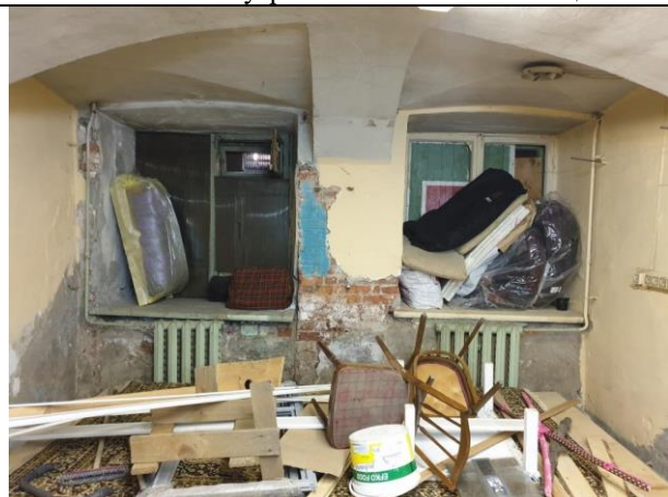
Фото № 18 – Внутреннее состояние помещения
