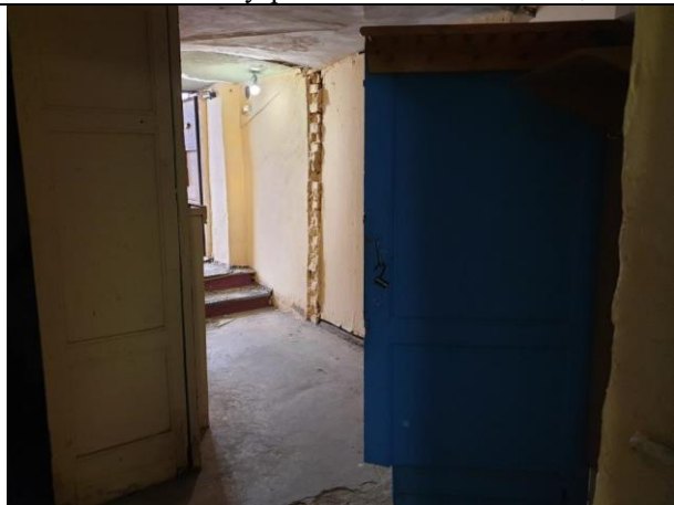
Фото № 21 – Внутреннее состояние помещения
