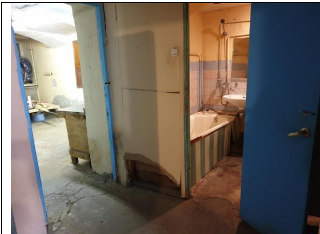
Фото № 15 – Внутреннее состояние помещения
