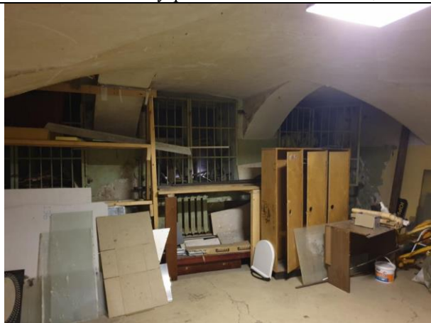
Фото № 13 – Внутреннее состояние помещения
