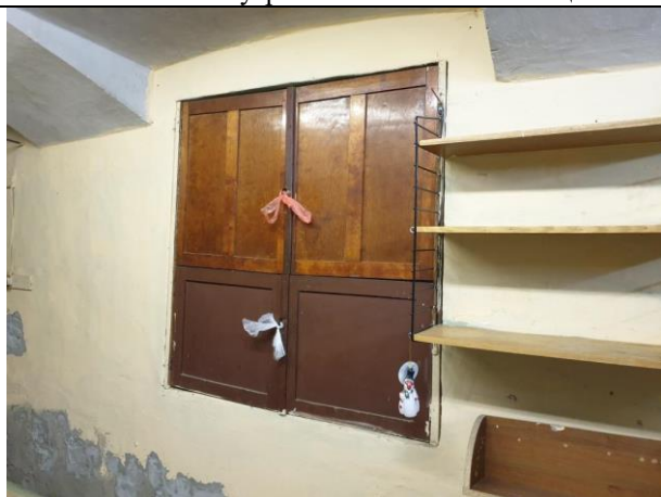
Фото № 19 – Внутреннее состояние помещения
