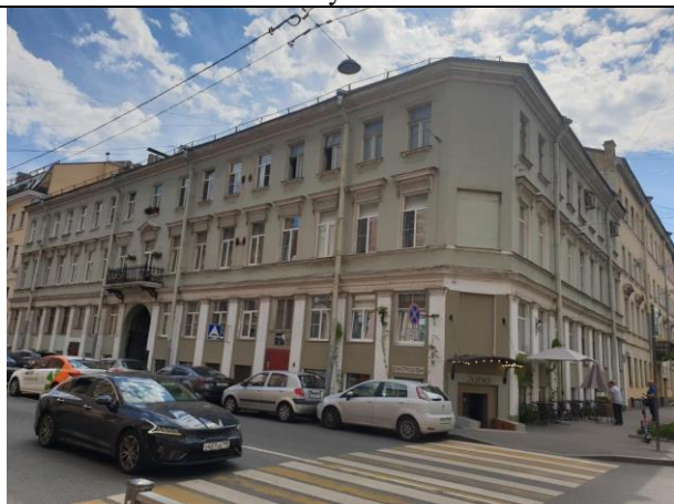
Фото № 3 – Здание, в котором находится Объект оценки
