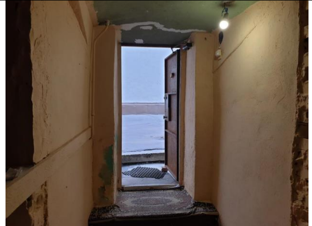
Фото № 10 – Внутреннее состояние помещения
