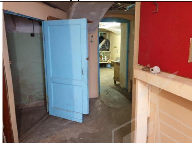
Фото № 22 – Внутреннее состояние помещения
