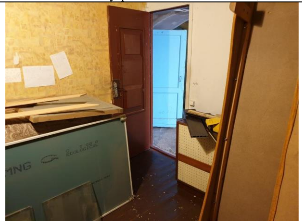
Фото № 12 – Внутреннее состояние помещения
