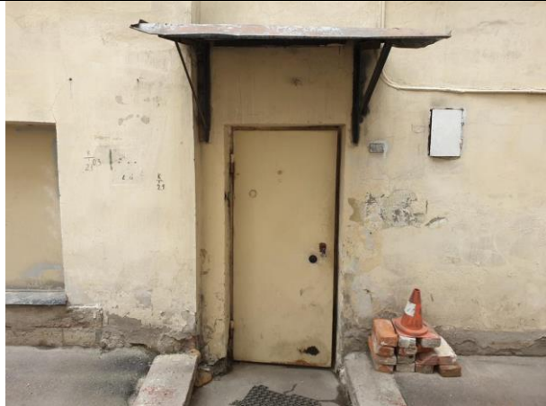
Фото № 9 – Вход в помещение
