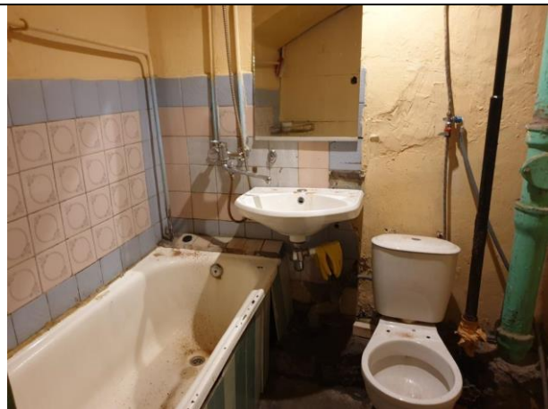
Фото № 16 – Внутреннее состояние помещения
