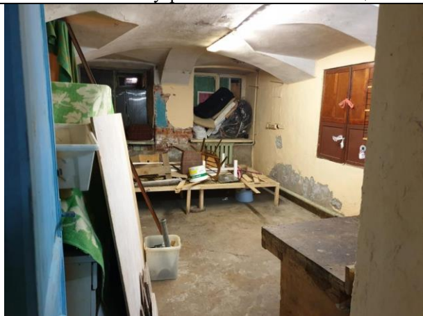
Фото № 17 – Внутреннее состояние помещения
