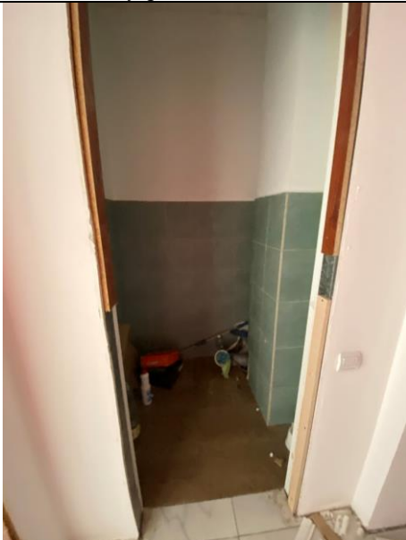
Фото № 21 – Внутреннее состояние помещения
