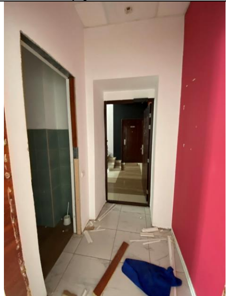
Фото № 22 – Внутреннее состояние помещения
