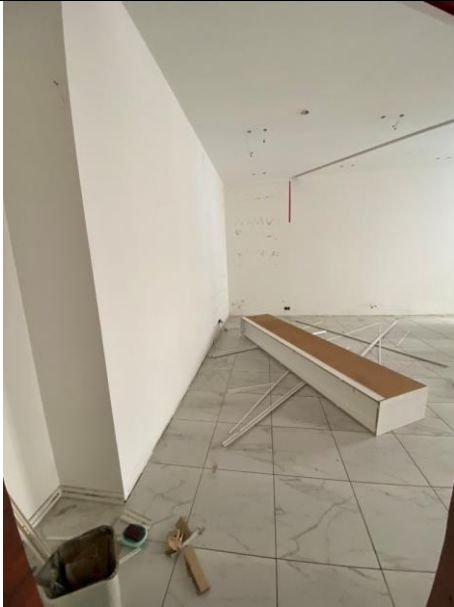
Фото № 19 – Внутреннее состояние помещения
