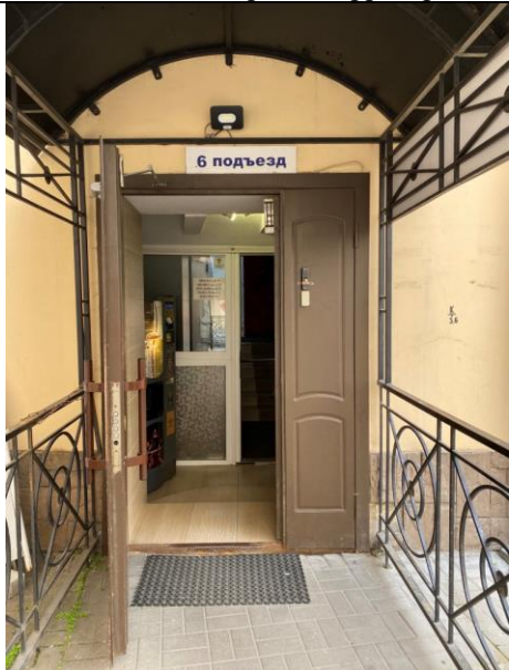
Фото № 7 – Внутреннее состояние помещения
