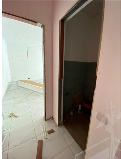
Фото № 24 – Внутреннее состояние помещения
