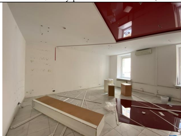
Фото № 17 – Внутреннее состояние помещения
