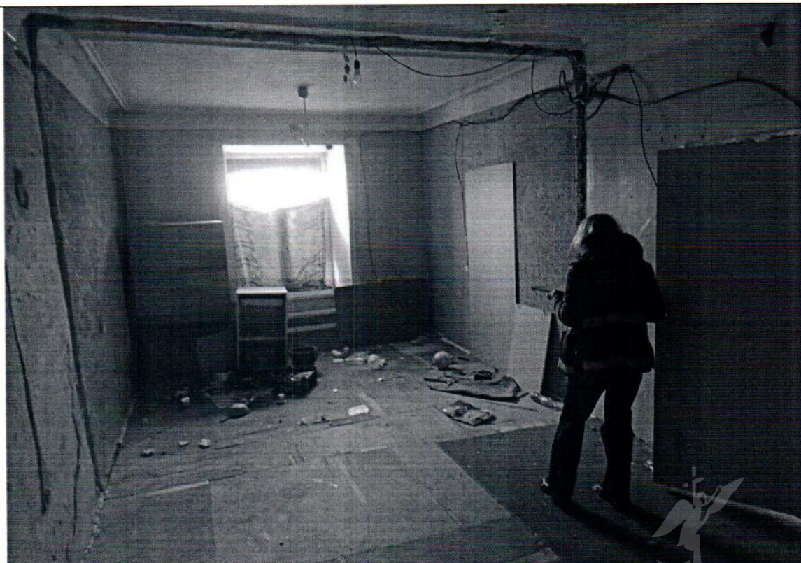
Описание: между ч.п. 5, ч.п. 6 и ч.п. 10 Объекта демонтированы перегородки с дверным проемом.
