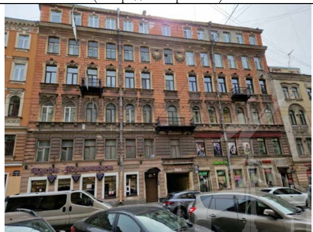
Фото 6. Вид здания расположения Объекта оценки
