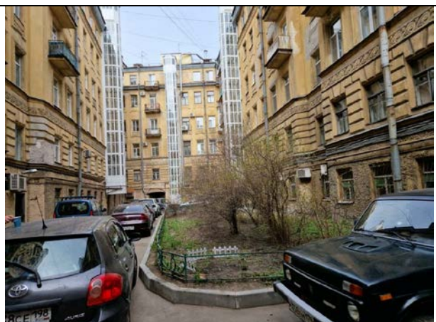
Фото 10. Внутри дворовая территория Объекта оценки
