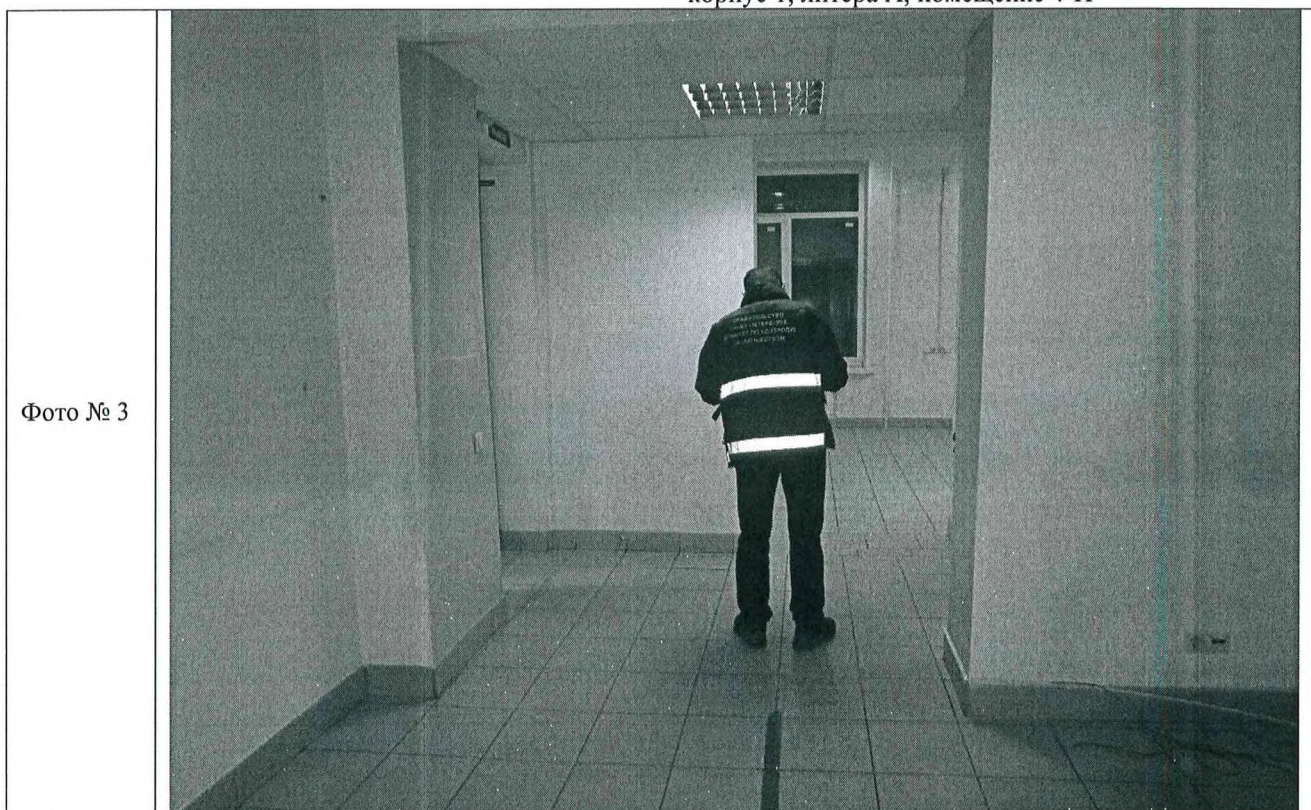
Описание: В ч.п. 3 и 8 Объекта заложен оконный проем
