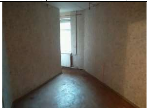
Фото 11. Внутреннее состояние Объекта оценки
