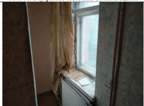
Фото 13. Внутреннее состояние Объекта оценки
