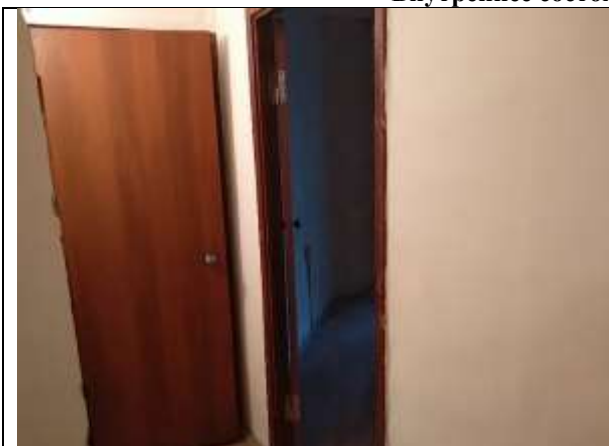
Фото 8. Внутреннее состояние Объекта оценки
