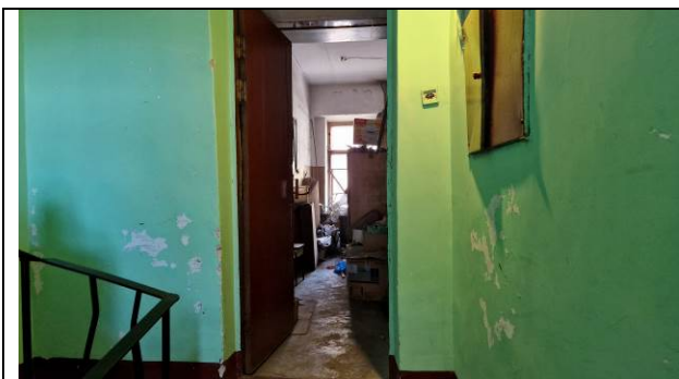
Фото 19. Вход в Объект оценки
