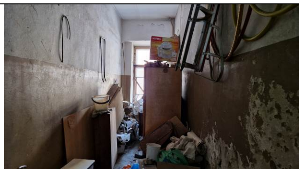
Фото 20. Типичное состояние Объекта оценки
