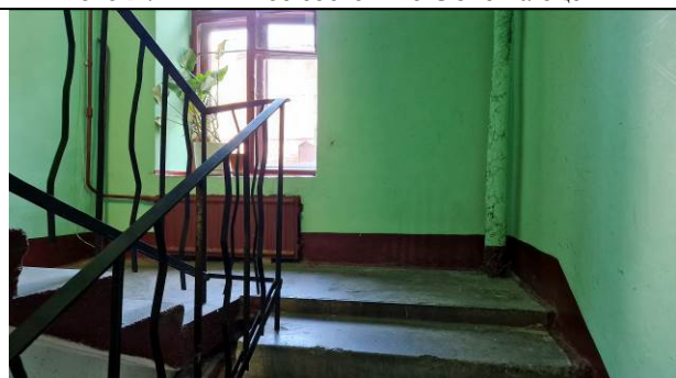
Фото 26. Типичное состояние лестничной клетки в парадной, где находится Объект оценки
