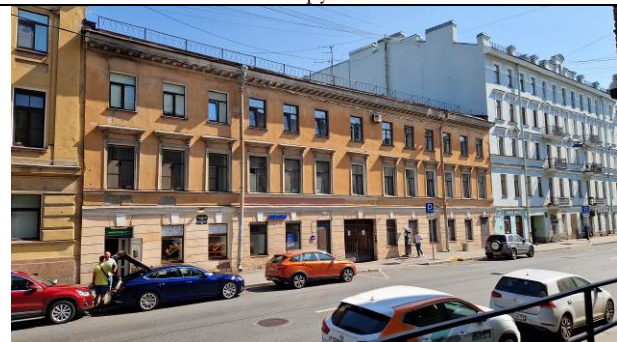
Фото 12. Вид здания расположения Объекта оценки
