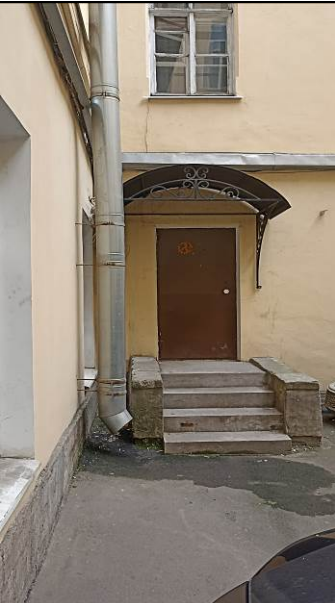
Фото 17. Вход в Объект оценки
