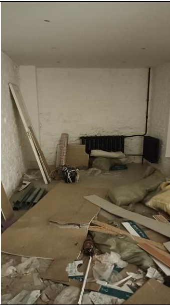
Фото 19. Типичное состояние объекта оценки
