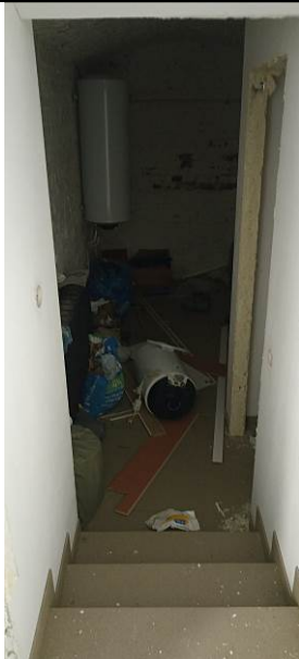
Фото 21. Типичное состояние Объекта оценки
