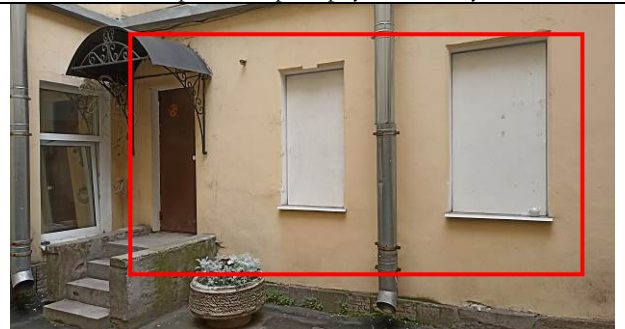
Фото 16. Вход и оконная группа Объекта оценки
