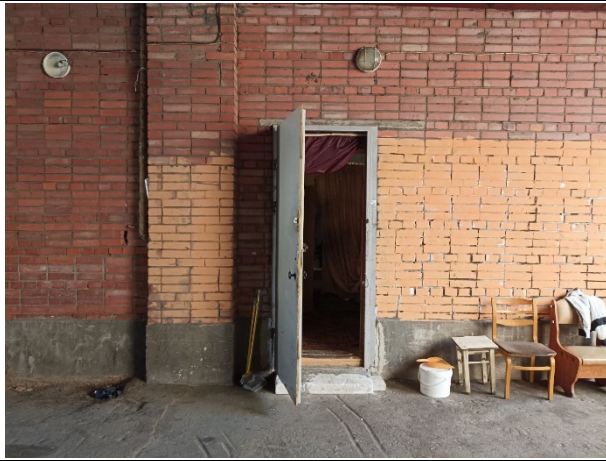
Фото № 5. Вход в помещение из-под арки
