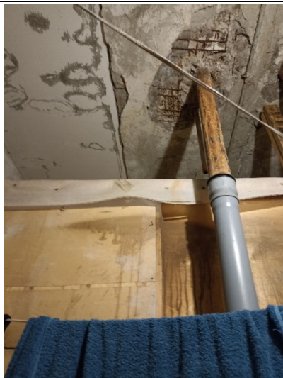
Фото № 9. Внутреннее состояние помещения
