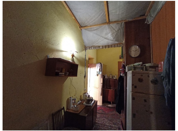
Фото № 12. Внутреннее состояние помещения
