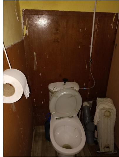
Фото № 8. Внутреннее состояние помещения
