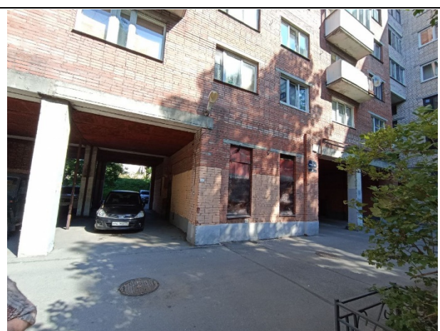
Фото № 2. Ближайшее окружение и подъездные пути
