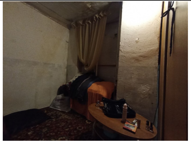
Фото № 14. Внутреннее состояние помещения
