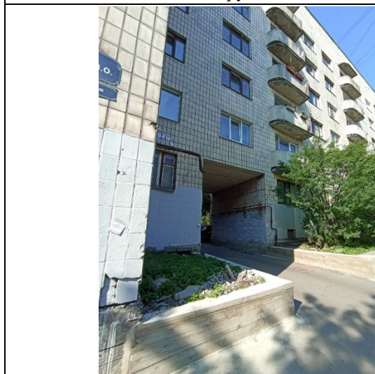
Фото № 3. Здание, в котором расположено помещение
