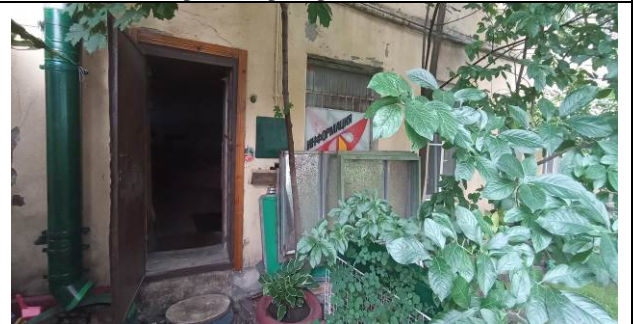
Фото 12. Вход и оконный проем Объекта оценки
