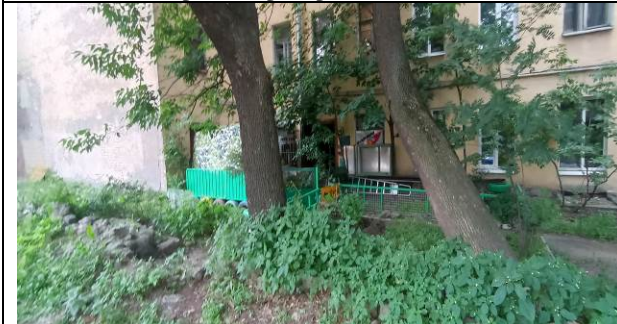
Фото 11. Вход в Объект оценки
