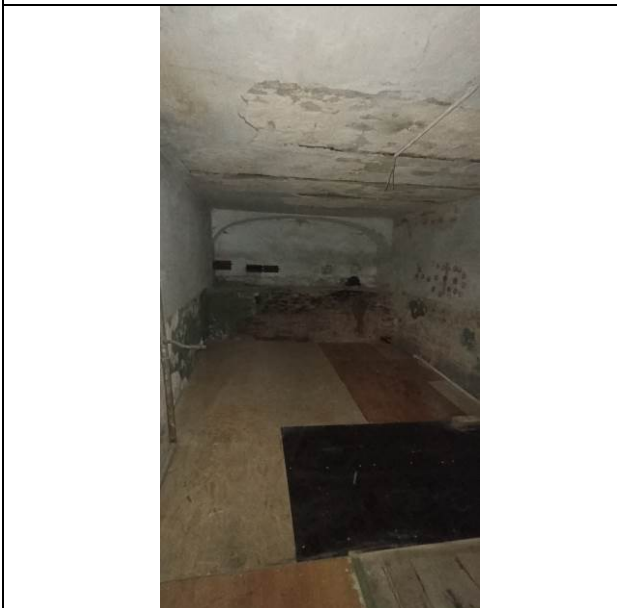
Фото 13. Типичное состояние Объекта оценки
