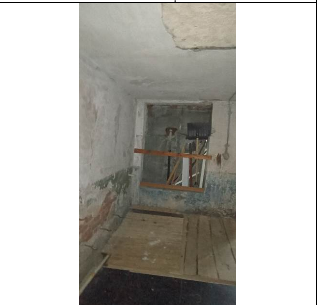
Фото 14. Типичное состояние Объекта оценки
