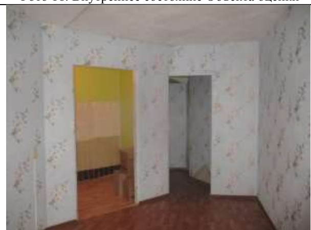
Фото 18. Внутреннее состояние Объекта оценки
