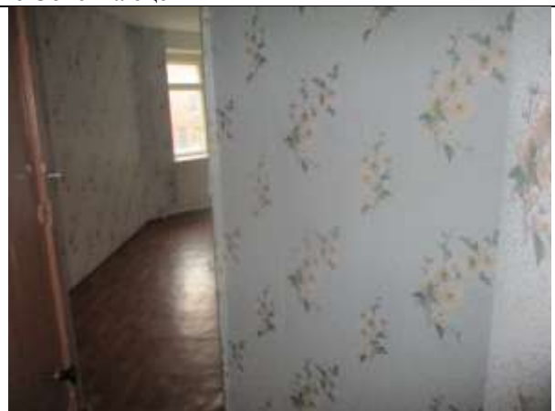
Фото 12. Внутреннее состояние Объекта оценки
