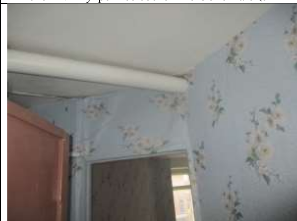
Фото 13. Внутреннее состояние Объекта оценки
