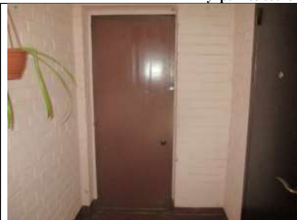
Фото 11. Внутреннее состояние Объекта оценки
