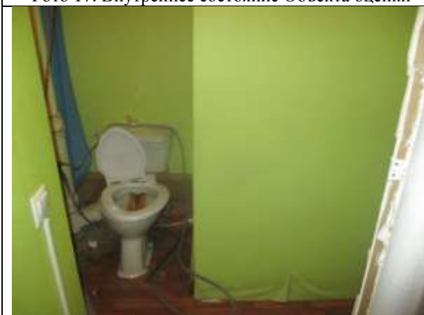
Фото 19. Внутреннее состояние Объекта оценки
