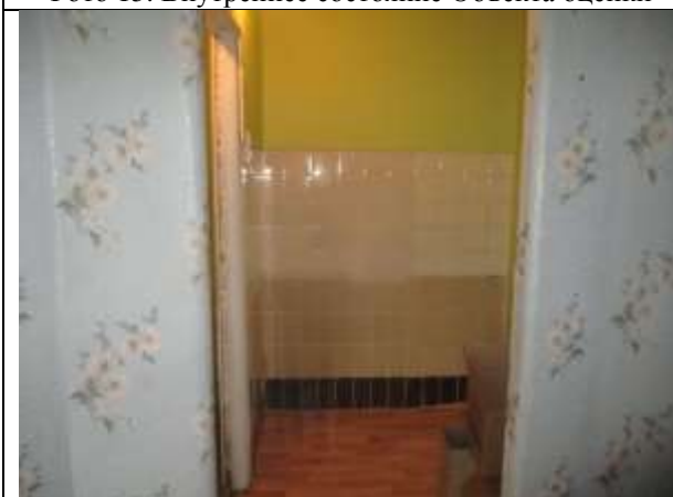
Фото 17. Внутреннее состояние Объекта оценки
