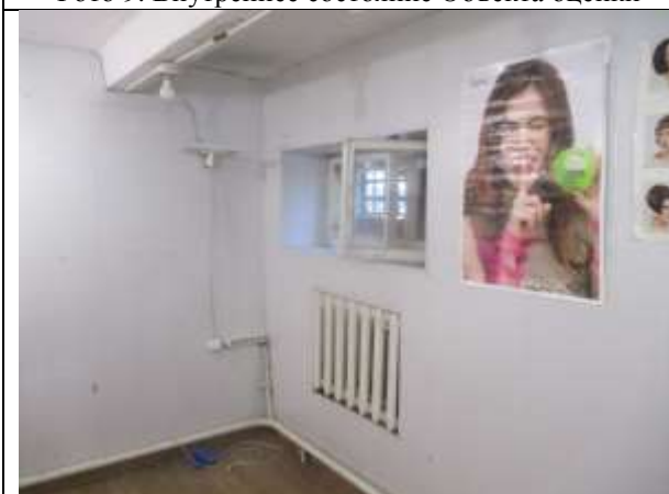
Фото 11. Внутреннее состояние Объекта оценки
