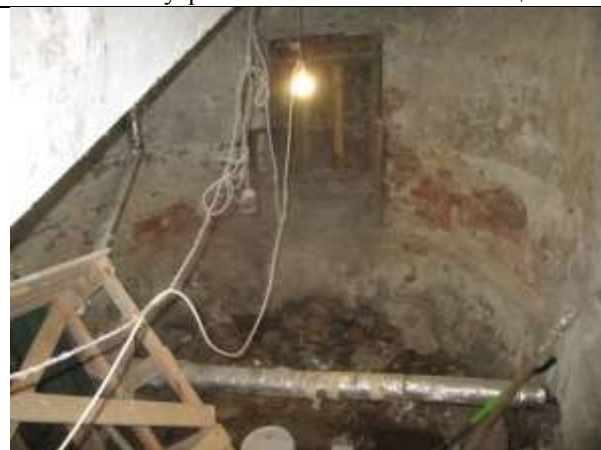
Фото 9. Внутреннее состояние Объекта оценки
