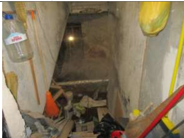
Фото 8. Внутреннее состояние Объекта оценки
