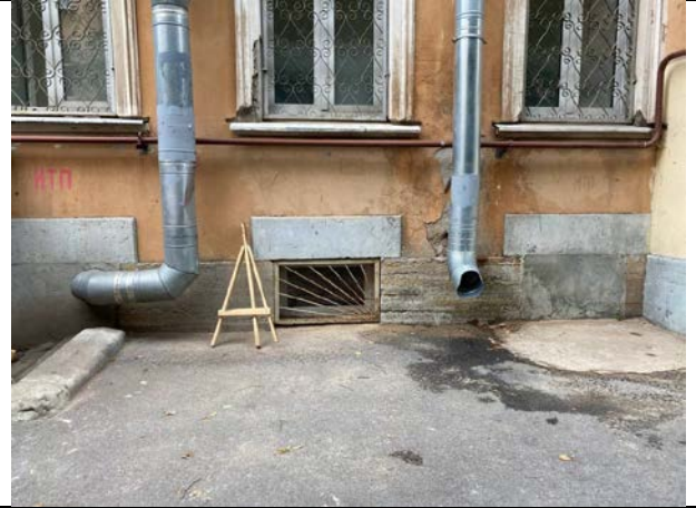
Фото № 14 – Окно в помещении со двора
