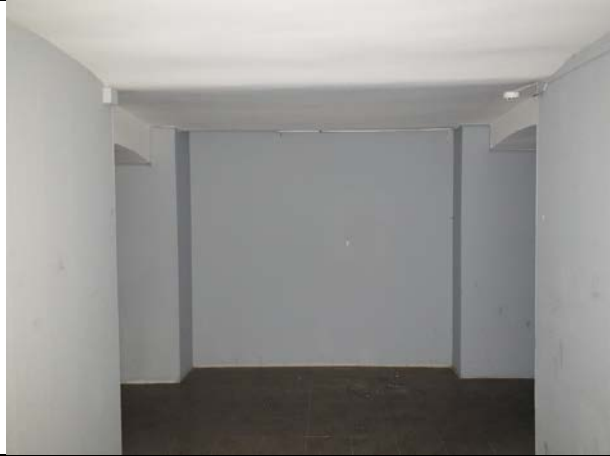
Фото № 5 – Внутреннее состояние (проход к водомерному узлу заложен)
