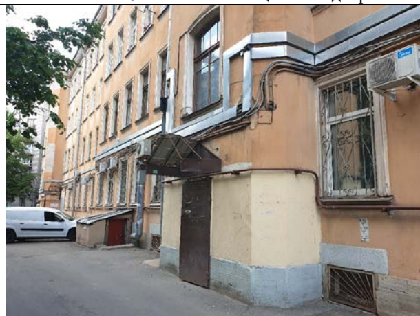
Фото № 17 - Фасад здания (внутри двора)
