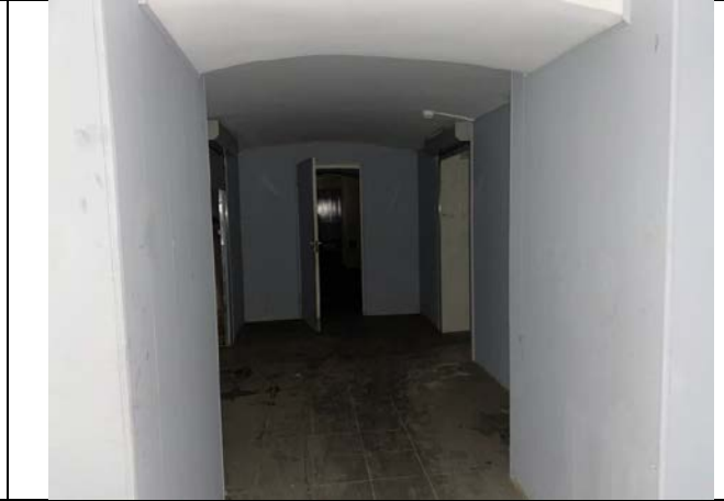
Фото № 6 - Внутренне состояние
