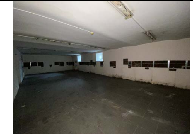
Фото № 8 - Внутреннее состояние
