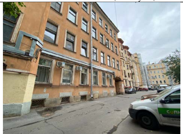
Фото № 18 - Фасад здания (внутри двора)
