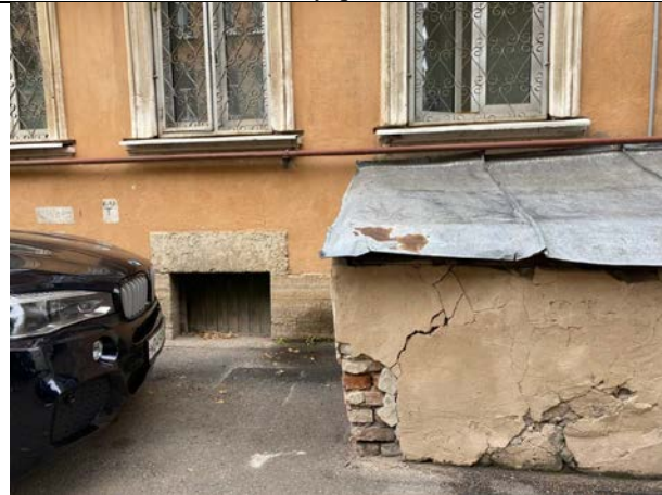
Фото № 15 – Окно в помещении со двора
