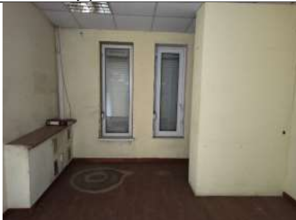
Фото 11. Внутреннее состояние Объекта оценки
