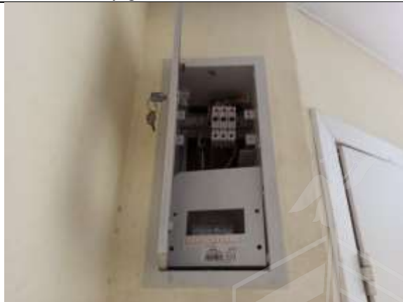
Фото 16. Внутреннее состояние Объекта оценки
