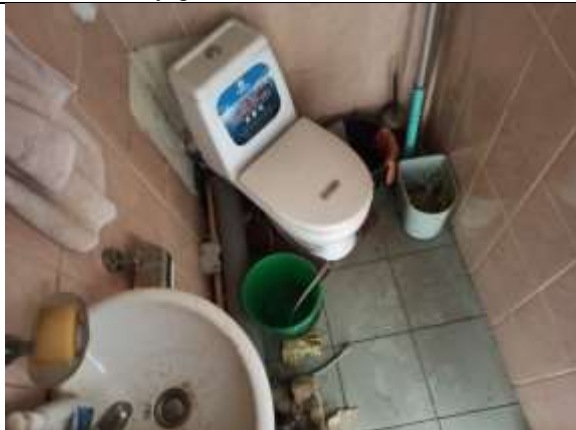
Фото 15. Внутреннее состояние Объекта оценки
