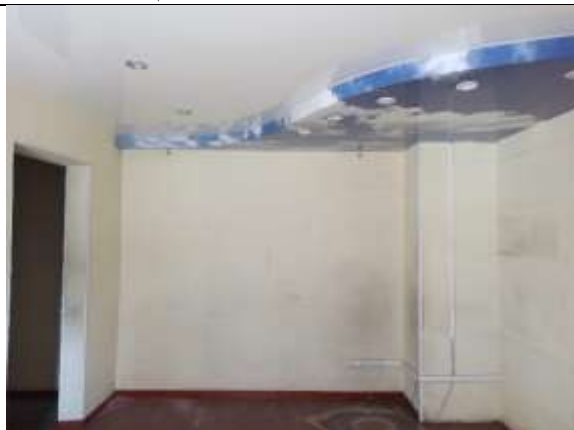
Фото 10. Внутреннее состояние Объекта оценки
