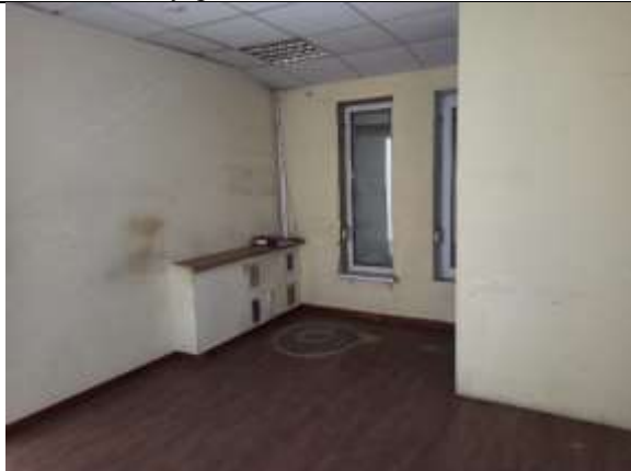
Фото 13. Внутреннее состояние Объекта оценки
