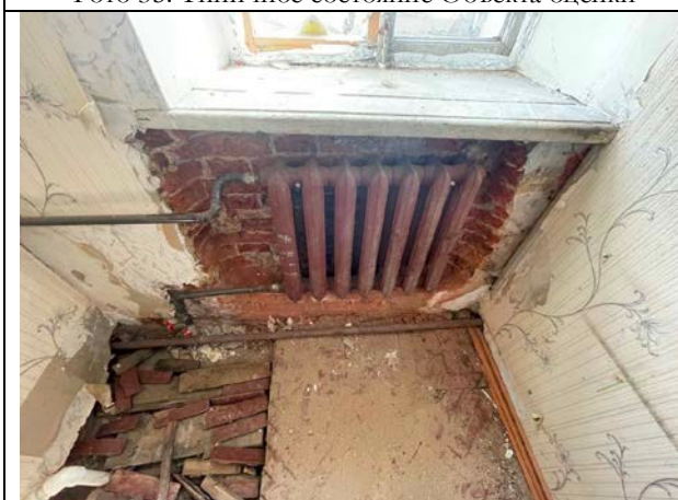
Фото 37. Типичное состояние Объекта оценки
