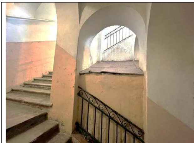
Фото 31. Лестничный проём Объекта оценки
