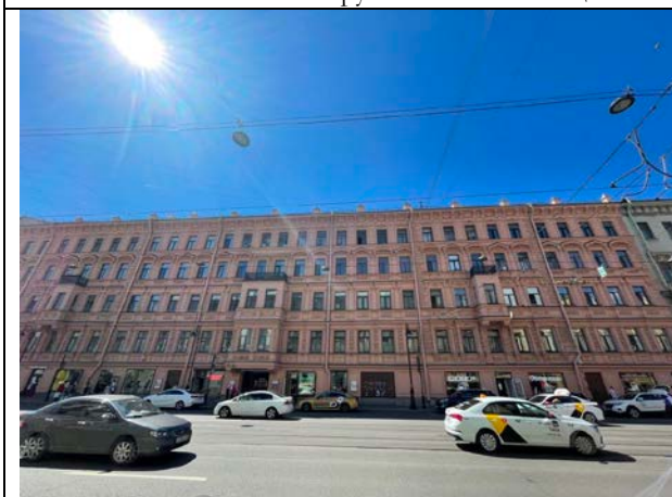
Фото 21. Вид здания расположения Объекта оценки
