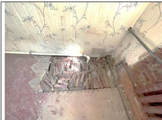
Фото 39. Типичное состояние Объекта оценки
