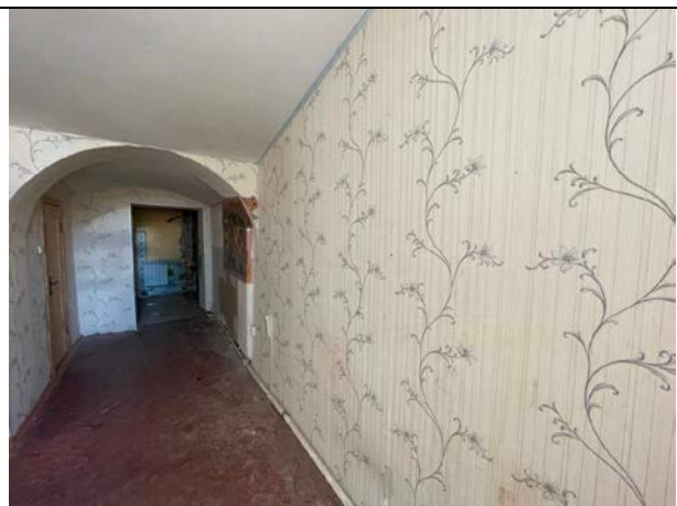
Фото 48. Типичное состояние Объекта оценки
