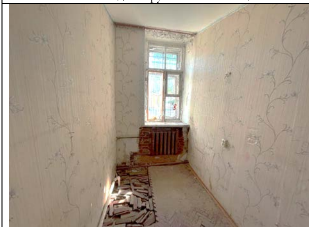
Фото 35. Типичное состояние Объекта оценки
