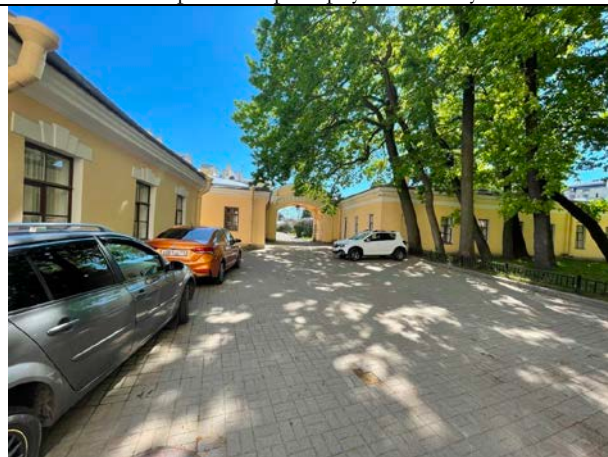
Фото 26. Внутри дворовая территория Объекта оценки
