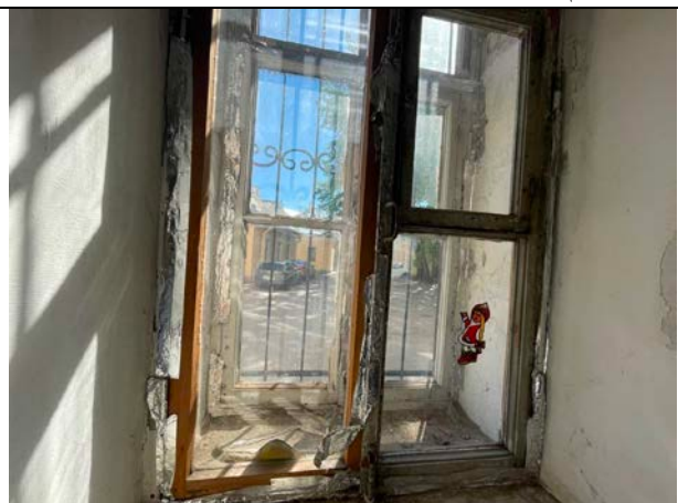
Фото 36. Типичное состояние Объекта оценки
