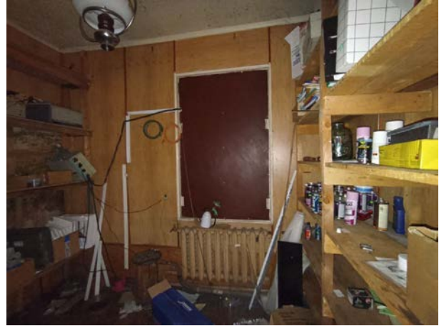
Фото № 8. Внутреннее состояние здания
