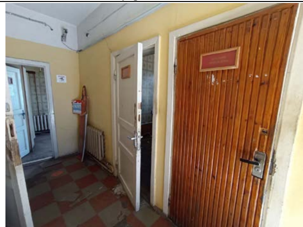
Фото № 17. Внутреннее состояние здания
