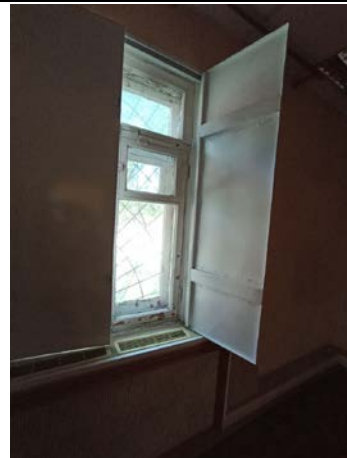
Фото № 10. Внутреннее состояние здания
