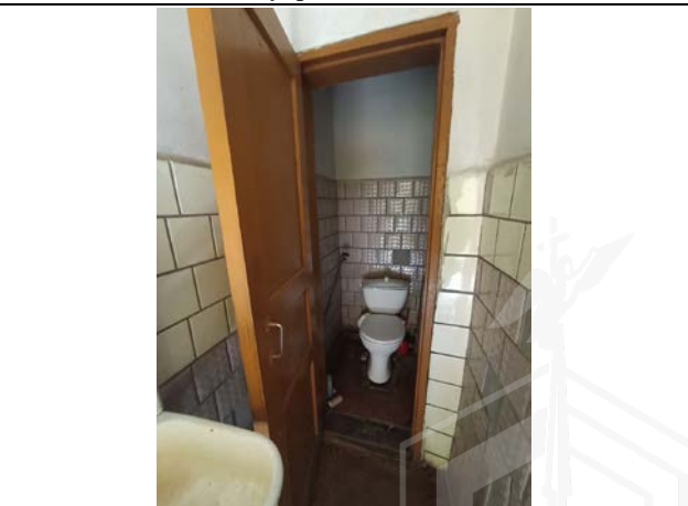
Фото № 20. Внутреннее состояние здания
