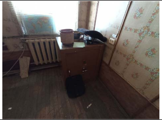
Фото № 14. Внутреннее состояние здания
