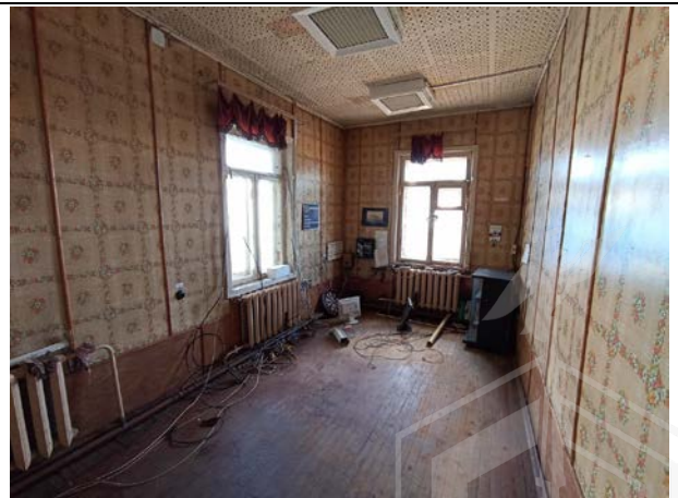
Фото № 12. Внутреннее состояние здания
