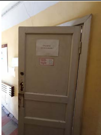
Фото № 9. Внутреннее состояние здания
