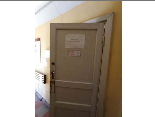
Фото № 9. Внутреннее состояние здания
