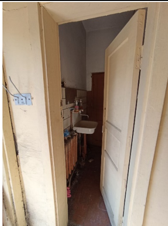
Фото № 21. Внутреннее состояние здания
