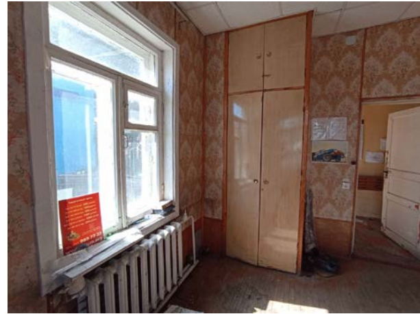
Фото № 15. Внутреннее состояние здания
