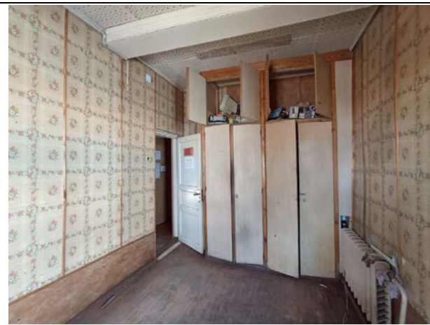
Фото № 13. Внутреннее состояние здания
