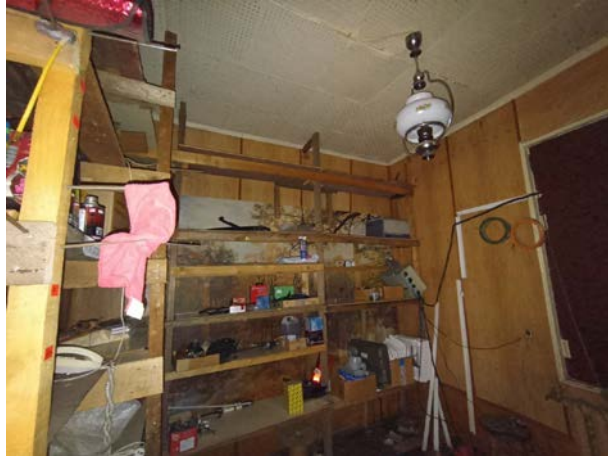
Фото № 7. Внутреннее состояние здания
