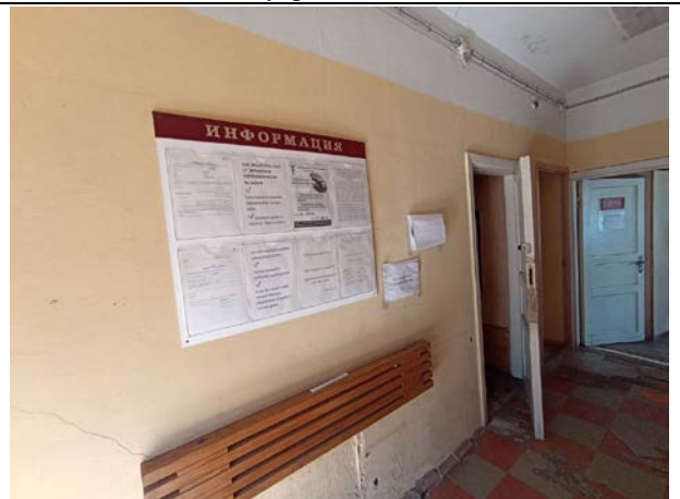
Фото № 18. Внутреннее состояние здания
