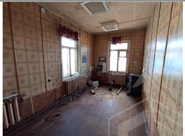
Фото № 12. Внутреннее состояние здания
