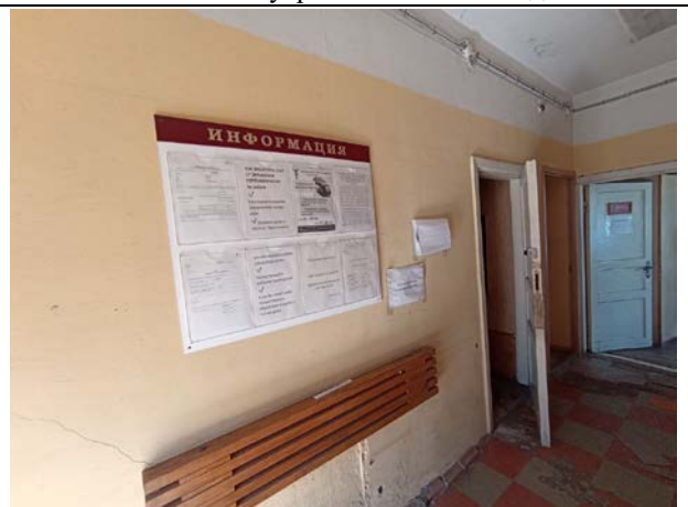
Фото № 18. Внутреннее состояние здания
