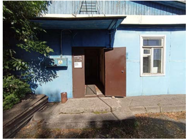
Фото № 6. Внешний вид земельного участка и здания
