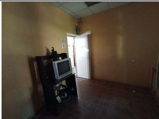
Фото № 11. Внутреннее состояние здания
