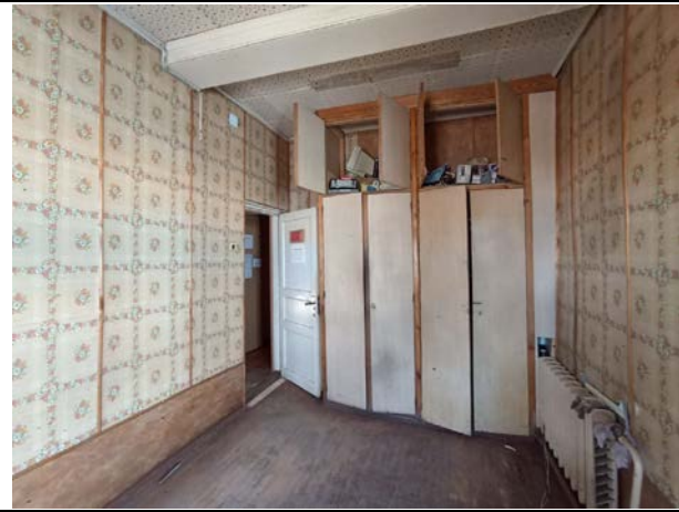
Фото № 13. Внутреннее состояние здания
