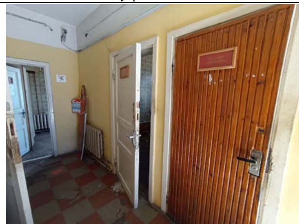
Фото № 17. Внутреннее состояние здания
