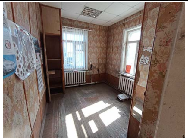
Фото № 16. Внутреннее состояние здания
