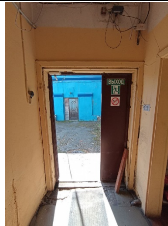
Фото № 22. Внутреннее состояние здания
