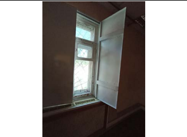
Фото № 10. Внутреннее состояние здания
