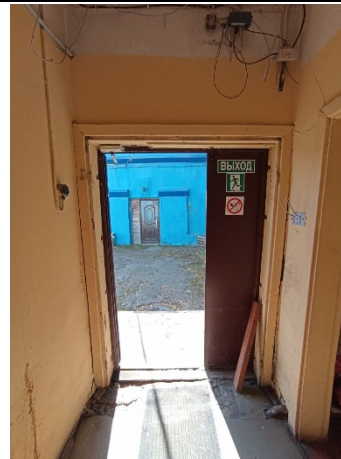
Фото № 22. Внутреннее состояние здания
