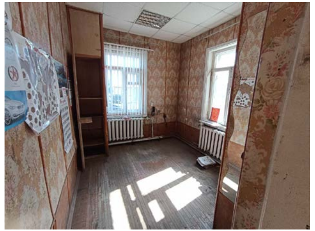
Фото № 16. Внутреннее состояние здания
