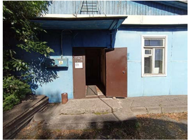
Фото № 6. Внешний вид земельного участка и здания
