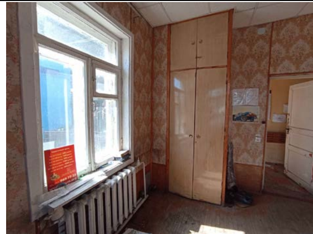
Фото № 15. Внутреннее состояние здания
