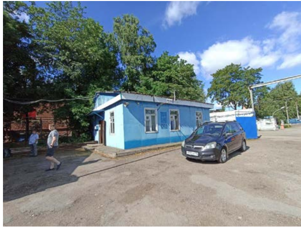
Фото № 5. Внешний вид земельного участка и здания
