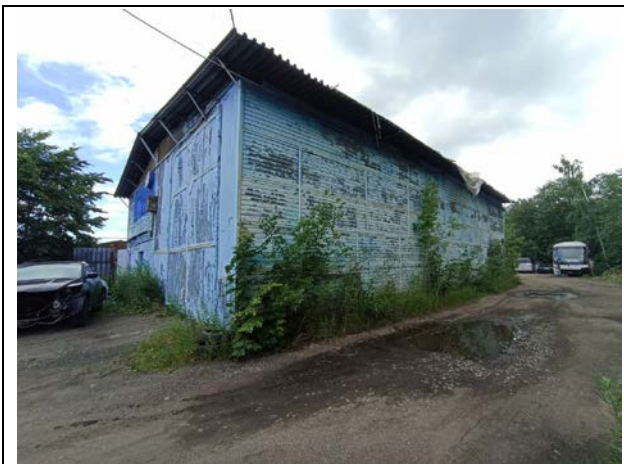
Фото № 5. Внешний вид земельного участка и здания
