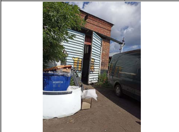
Фото № 9. Внешний вид земельного участка и здания
