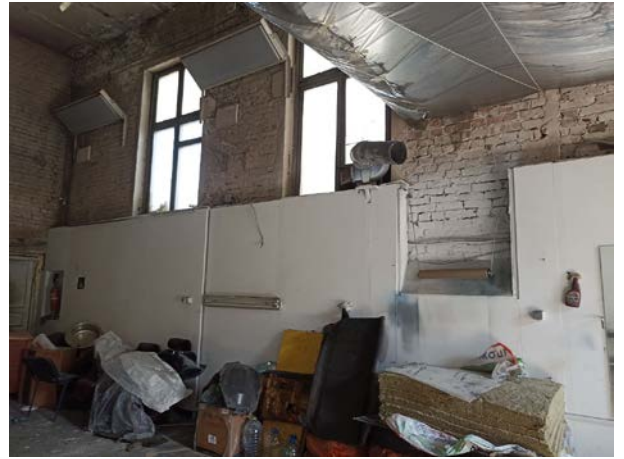
Фото № 16. Внутреннее состояние здания
