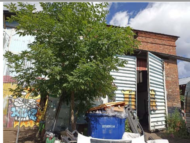
Фото № 8. Внешний вид земельного участка и здания
