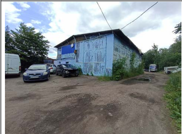
Фото № 7. Внешний вид земельного участка и здания
