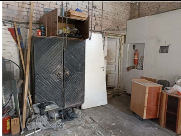
Фото № 19. Внутреннее состояние здания
