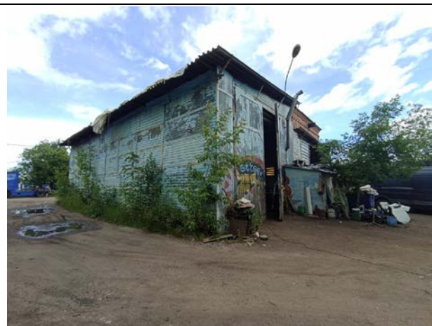
Фото № 6. Внешний вид земельного участка и здания
