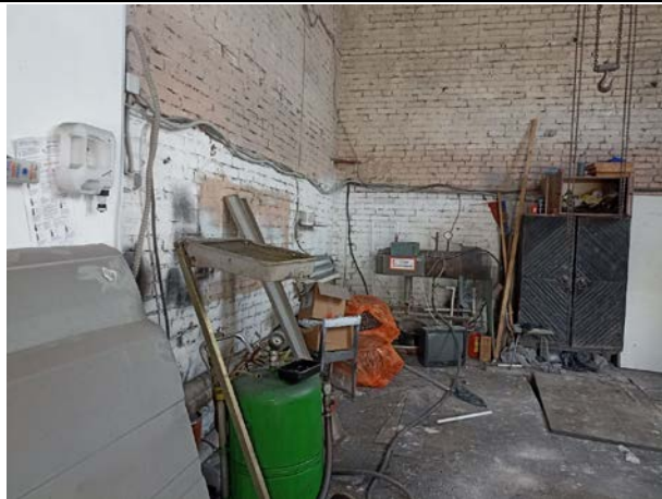
Фото № 17. Внутреннее состояние здания
