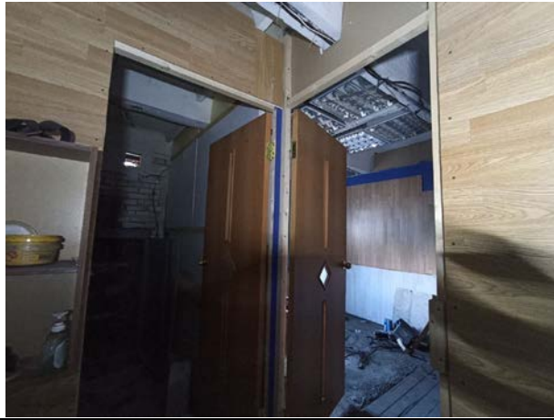
Фото № 13. Внутреннее состояние здания
