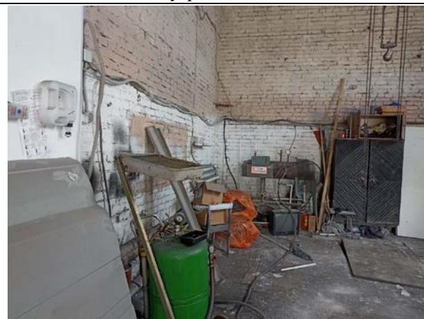
Фото № 17. Внутреннее состояние здания
