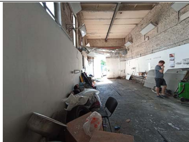
Фото № 14. Внутреннее состояние здания
