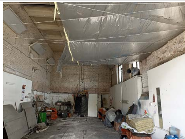
Фото № 15. Внутреннее состояние здания
