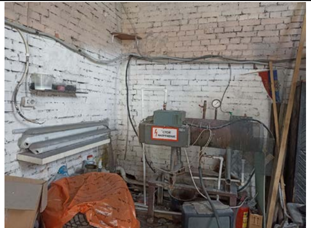
Фото № 18. Внутреннее состояние здания
