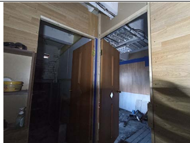
Фото № 13. Внутреннее состояние здания
