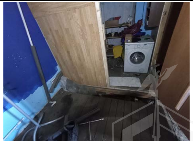
Фото № 20. Внутреннее состояние здания
