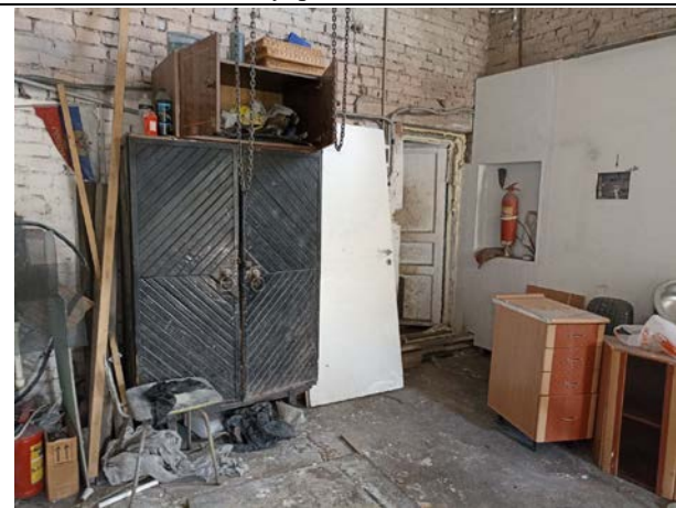
Фото № 19. Внутреннее состояние здания
