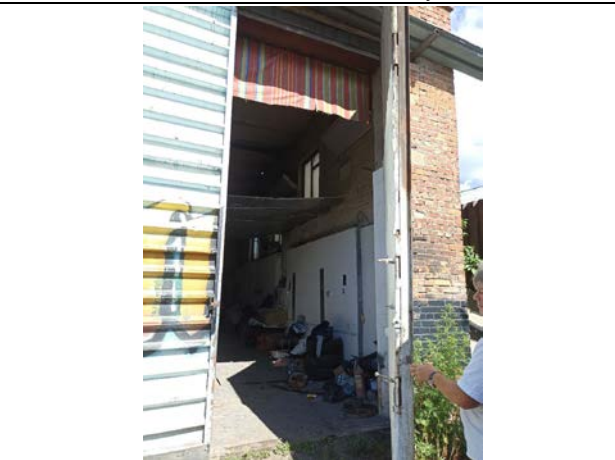
Фото № 10. Внешний вид земельного участка и здания
