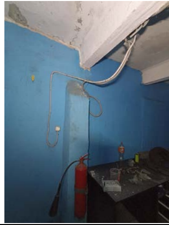
Фото № 22. Внутреннее состояние здания
