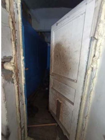
Фото № 23. Внутреннее состояние здания
