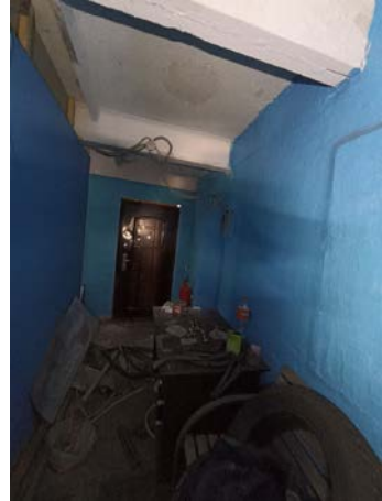
Фото № 24. Внутреннее состояние здания
