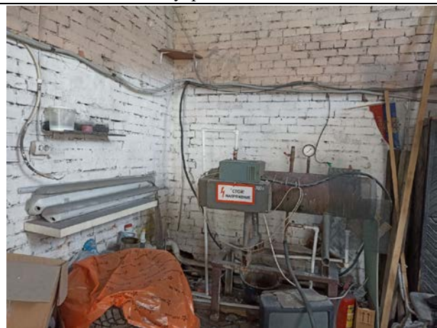
Фото № 18. Внутреннее состояние здания
