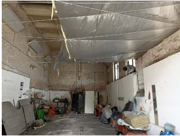
Фото № 15. Внутреннее состояние здания
