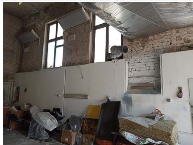
Фото № 16. Внутреннее состояние здания
