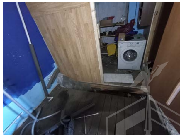
Фото № 20. Внутреннее состояние здания
