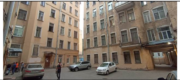
Фото 18. Внутри дворовое пространство здания расположения Объекта оценки
