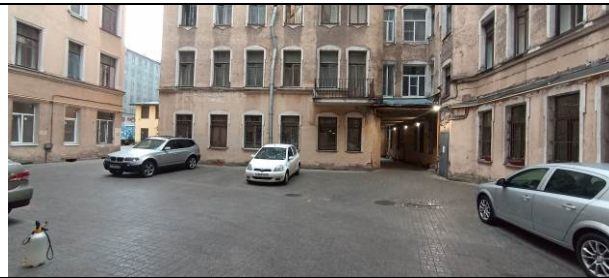
Фото 17. Внутри дворовое пространство здания расположения Объекта оценки
