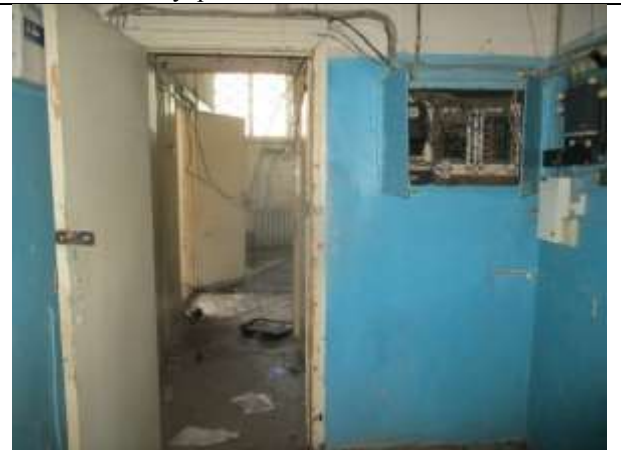
Фото 26. Внутреннее состояние Объекта оценки
