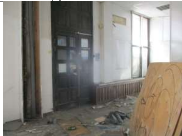
Фото 25. Внутреннее состояние Объекта оценки
