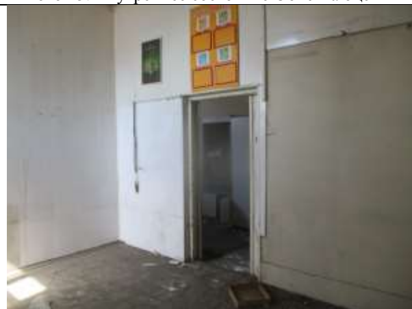
Фото 27. Внутреннее состояние Объекта оценки
