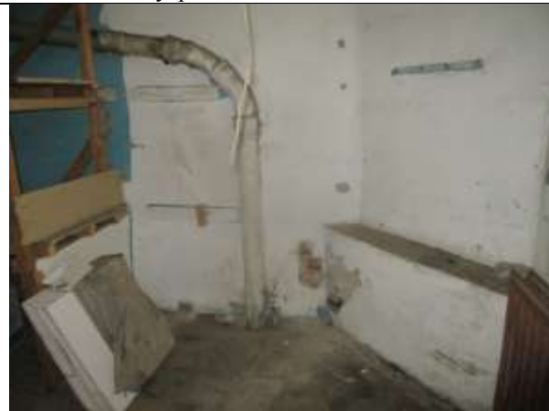
Фото 17. Внутреннее состояние Объекта оценки
