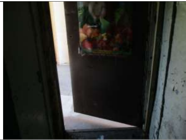
Фото 15. Внутреннее состояние Объекта оценки
