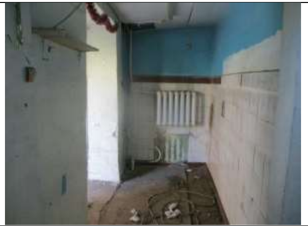
Фото 16. Внутреннее состояние Объекта оценки
