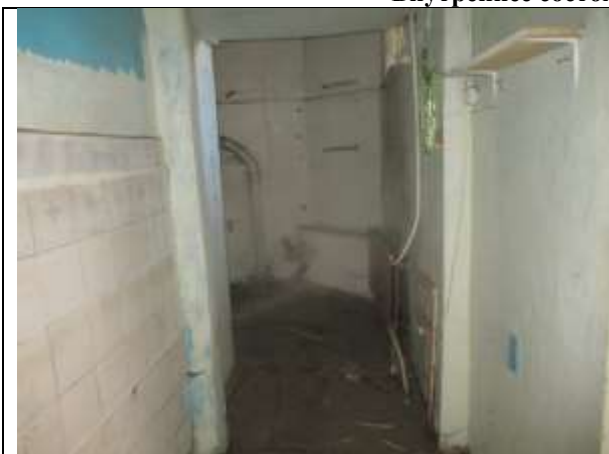
Фото 13. Внутреннее состояние Объекта оценки
