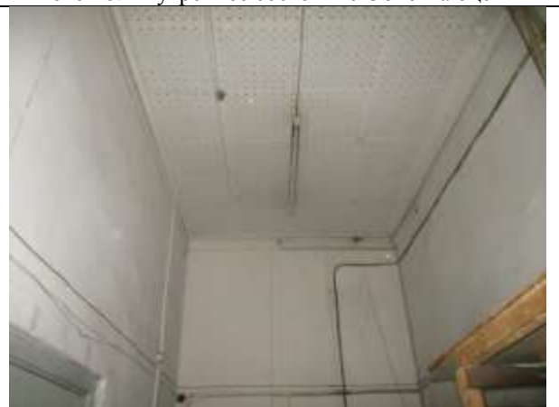
Фото 20. Внутреннее состояние Объекта оценки
