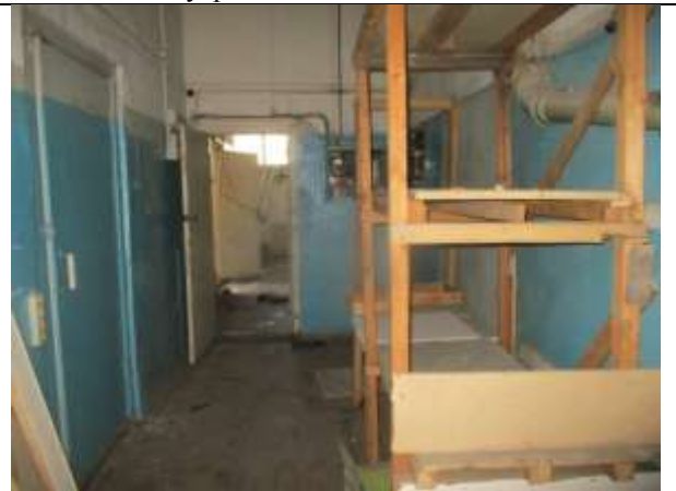
Фото 18. Внутреннее состояние Объекта оценки
