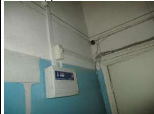
Фото 33. Внутреннее состояние Объекта оценки
