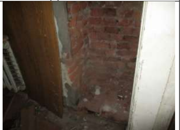
Фото 34. Внутреннее состояние Объекта оценки
