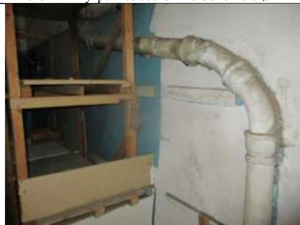
Фото 19. Внутреннее состояние Объекта оценки
