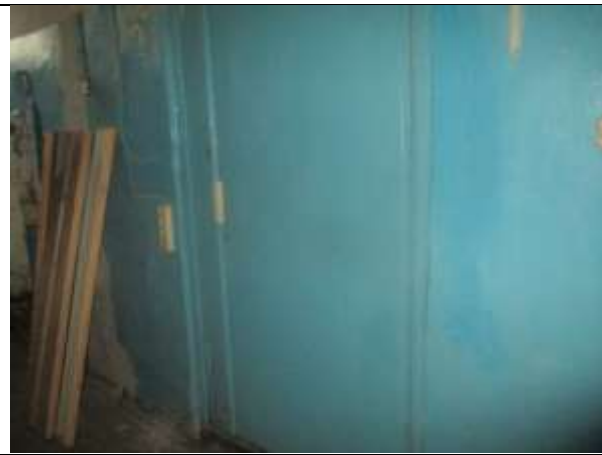
Фото 23. Внутреннее состояние Объекта оценки
