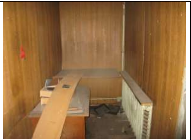
Фото 32. Внутреннее состояние Объекта оценки
