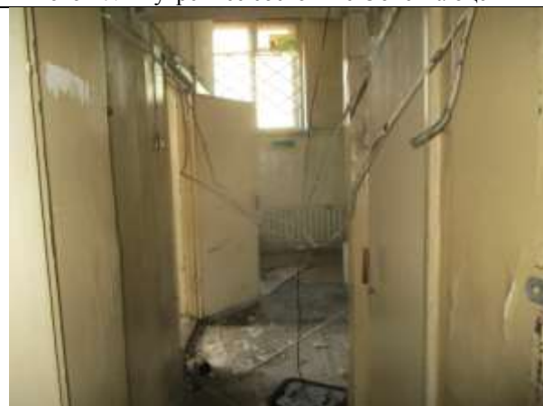
Фото 29. Внутреннее состояние Объекта оценки
