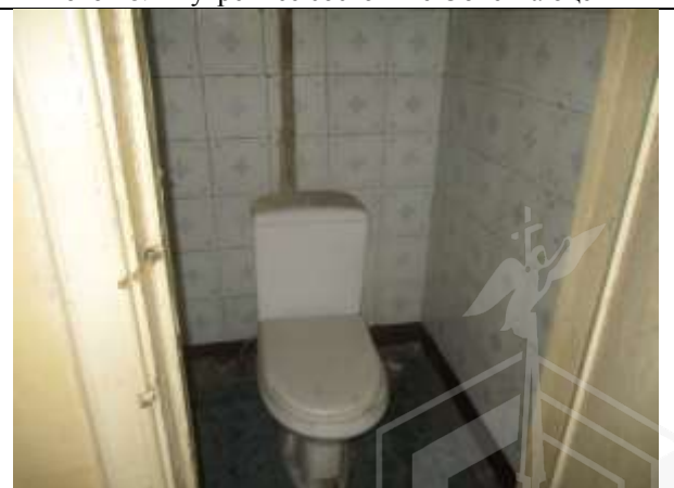
Фото 30. Внутреннее состояние Объекта оценки
