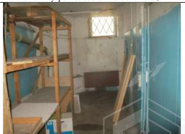
Фото 22. Внутреннее состояние Объекта оценки
