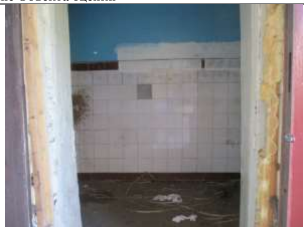
Фото 14. Внутреннее состояние Объекта оценки
