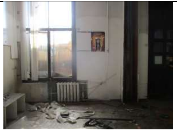
Фото 24. Внутреннее состояние Объекта оценки
