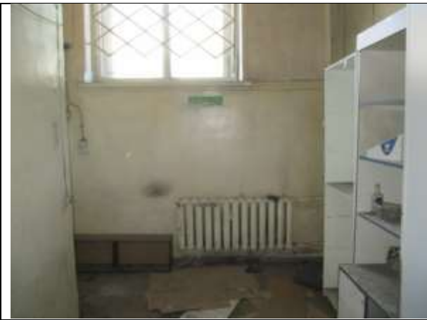
Фото 31. Внутреннее состояние Объекта оценки
