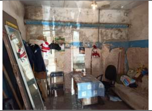
Фото 13. Внутреннее состояние Объекта оценки
