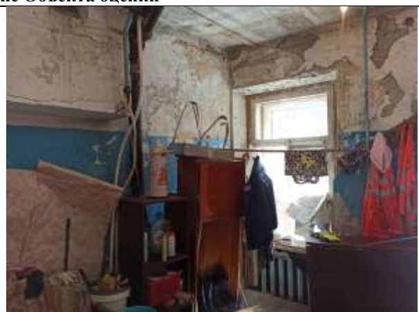
Фото 11. Внутреннее состояние Объекта оценки
