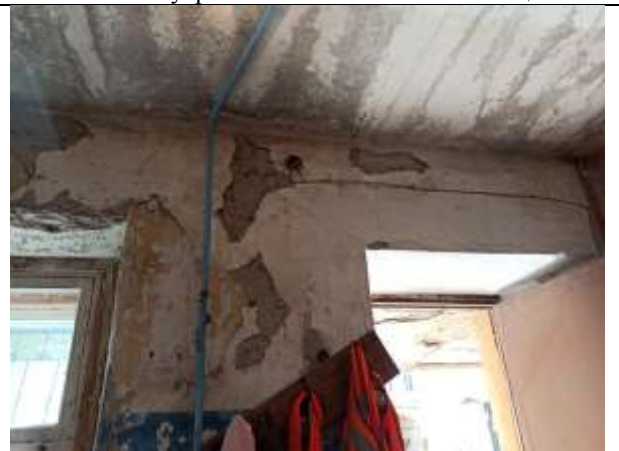
Фото 17. Внутреннее состояние Объекта оценки
