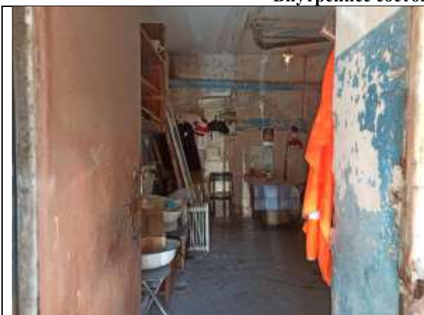
Фото 10. Внутреннее состояние Объекта оценки
