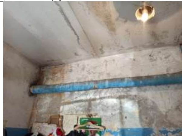
Фото 14. Внутреннее состояние Объекта оценки
