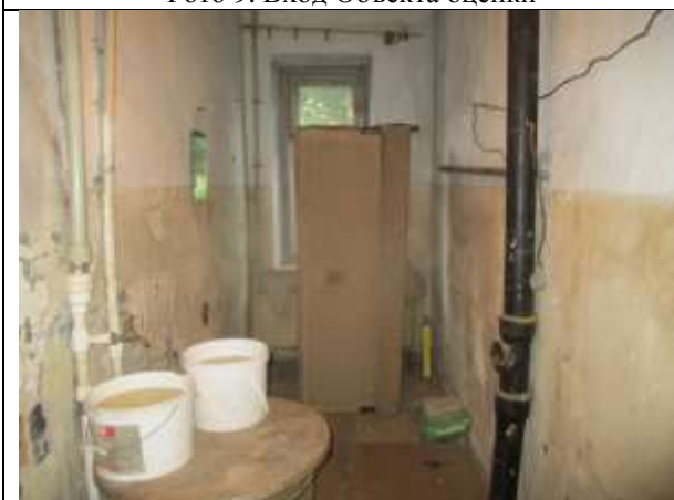
Фото 11. Внутреннее состояние Объекта оценки
