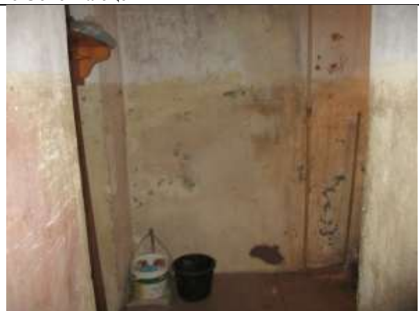
Фото 10. Внутреннее состояние Объекта оценки
