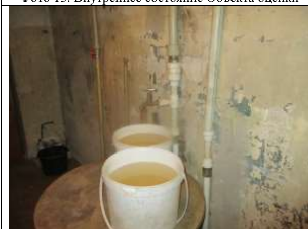
Фото 15. Внутреннее состояние Объекта оценки
