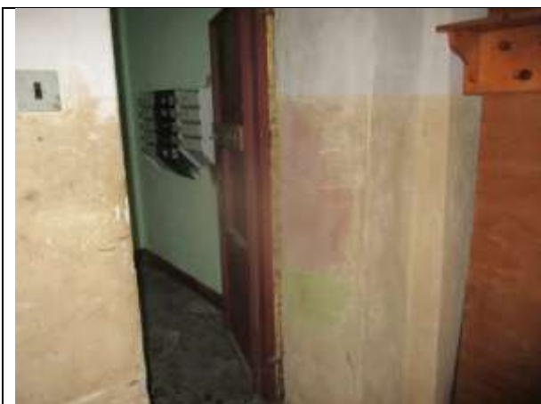
Фото 13. Внутреннее состояние Объекта оценки
