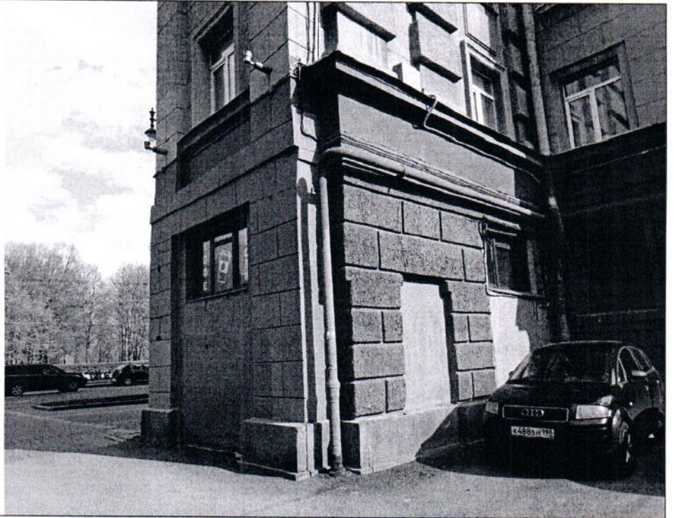
Описание: Вид на Объект снаружи
