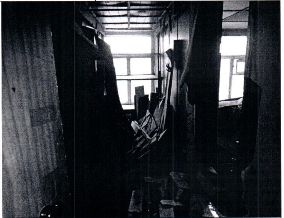
Описание: Вид внутри Объекта (ч.п. 1)
