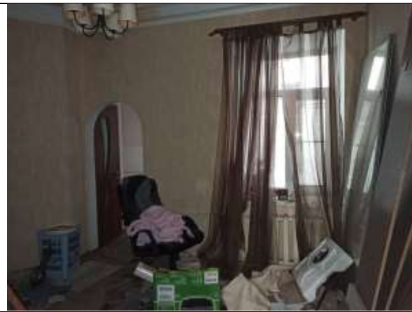
Фото 13. Внутреннее состояние Объекта оценки
