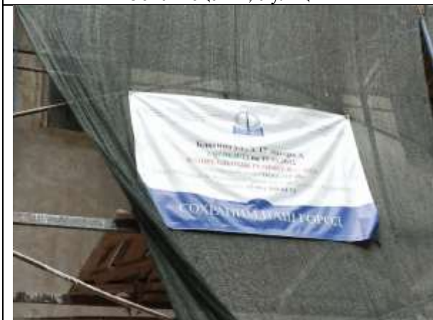
Фото 3. Вид здания, в котором расположен Объект оценки (сведения о капитальном ремонте)
