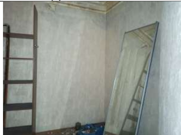
Фото 15. Внутреннее состояние Объекта оценки
