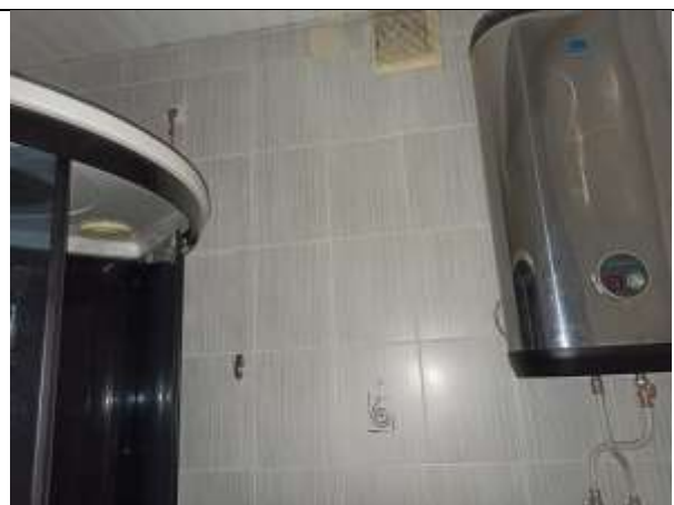
Фото 22. Внутреннее состояние Объекта оценки
