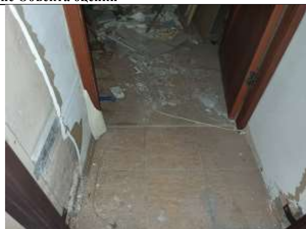
Фото 12. Внутреннее состояние Объекта оценки
