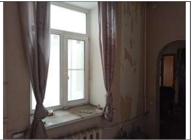
Фото 14. Внутреннее состояние Объекта оценки
