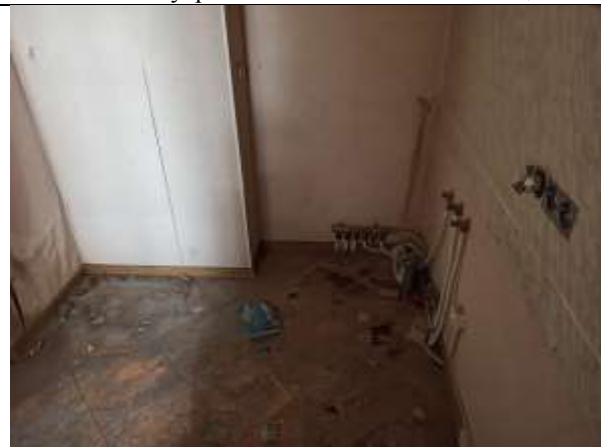
Фото 19. Внутреннее состояние Объекта оценки
