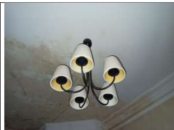
Фото 21. Внутреннее состояние Объекта оценки
