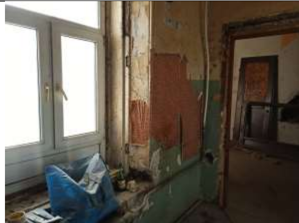
Фото 15. Внутреннее состояние Объекта оценки
