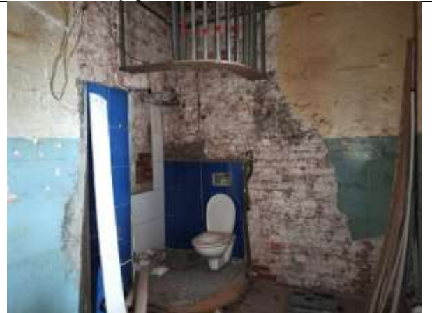
Фото 18. Внутреннее состояние Объекта оценки
