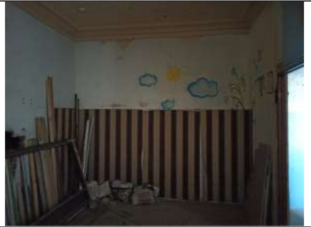
Фото 14. Внутреннее состояние Объекта оценки
