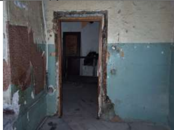
Фото 17. Внутреннее состояние Объекта оценки
