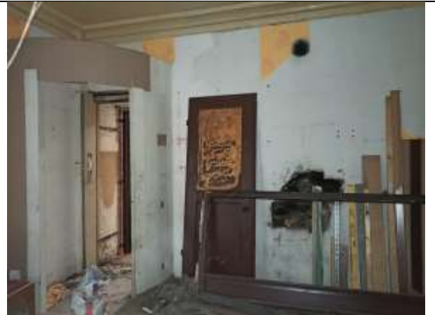
Фото 16. Внутреннее состояние Объекта оценки
