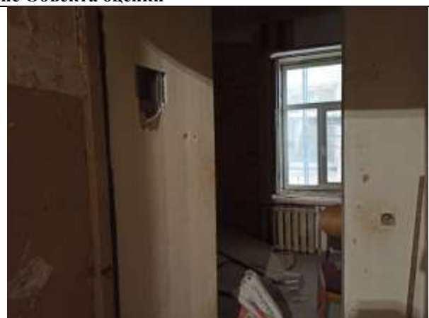
Фото 12. Внутреннее состояние Объекта оценки
