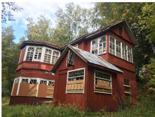
Фото 7.1. Вид на здание размещения Объекта оценки.
