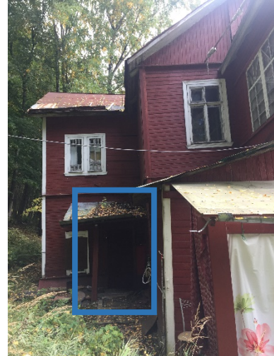
Фото 7.6. Вид на здание размещения Объекта оценки. Общий вход в подъезд.
