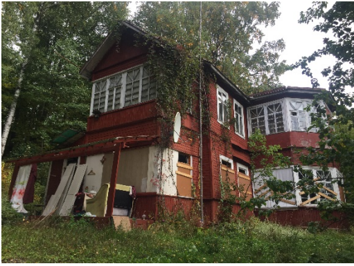
Фото 7.3. Вид на здание размещения Объекта оценки.
