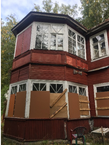
Фото 7.5. Вид на здание размещения Объекта оценки.
