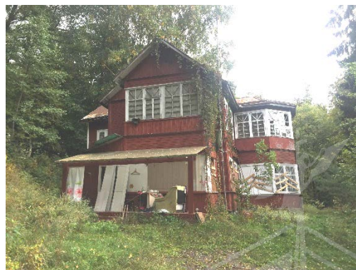
Фото 7.2. Вид на здание размещения Объекта оценки.
