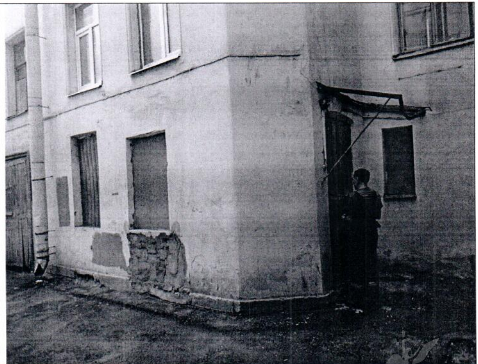
Описание: Вид на Объект
