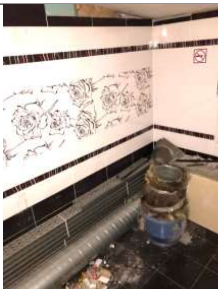
Фото 11. Внутреннее состояние Объекта оценки
