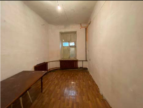
Фото № 13 – Внутреннее состояние помещения
