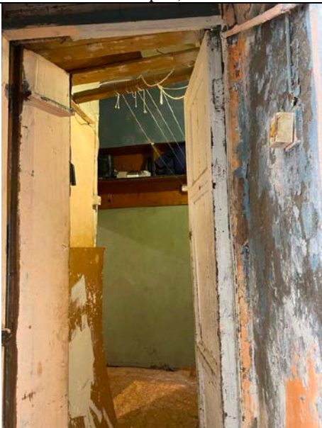
Фото № 9 – Внутреннее состояние помещения
