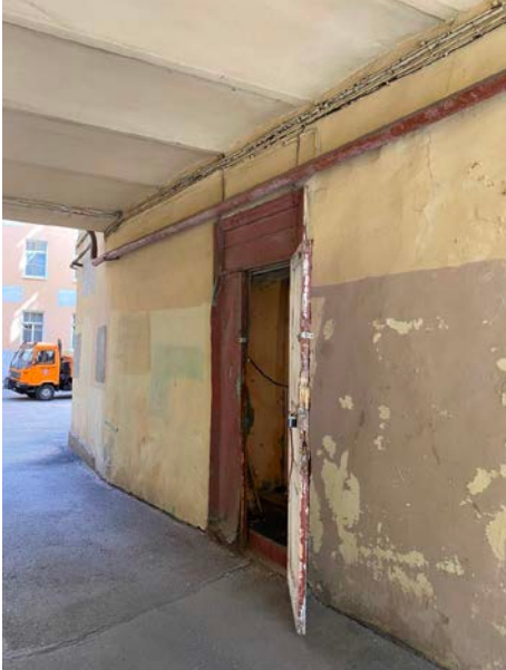
Фото № 7 – Вход в помещение (отдельный из-под арки)
