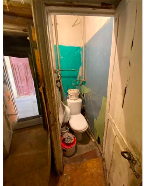
Фото № 18 – Внутреннее состояние помещения
