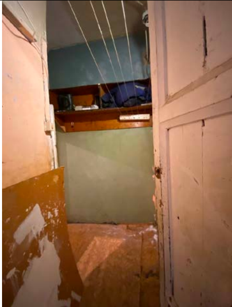
Фото № 11 – Внутреннее состояние помещения
