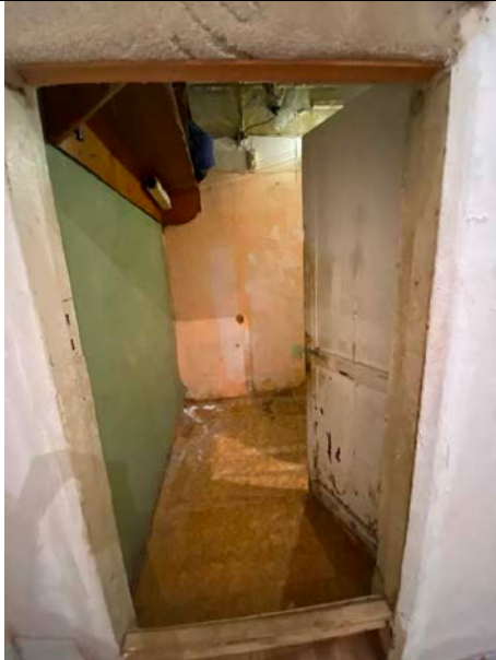
Фото № 17 – Внутреннее состояние помещения
