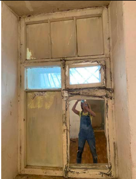
Фото № 15 – Внутреннее состояние помещения
