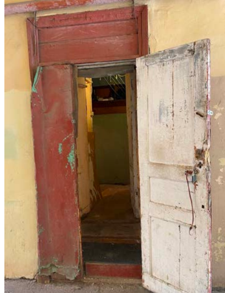
Фото № 8 – Вход в помещение (отдельный из-под арки)
