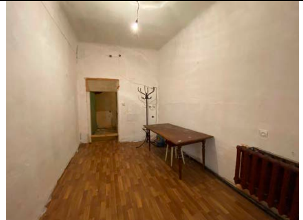
Фото № 14 – Внутреннее состояние помещения
