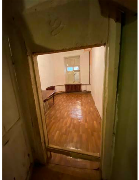
Фото № 12 – Внутреннее состояние помещения
