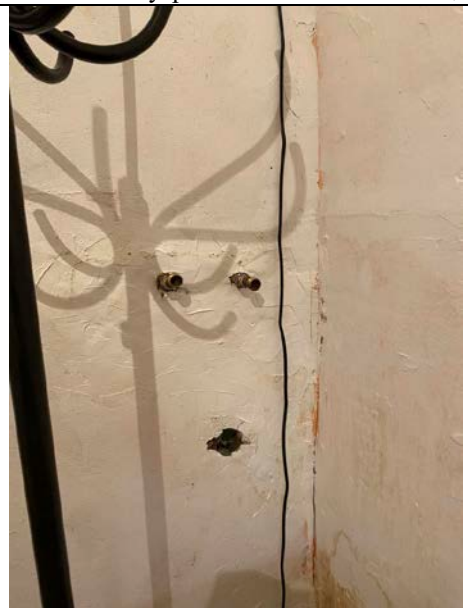
Фото № 20 – Внутреннее состояние помещения
