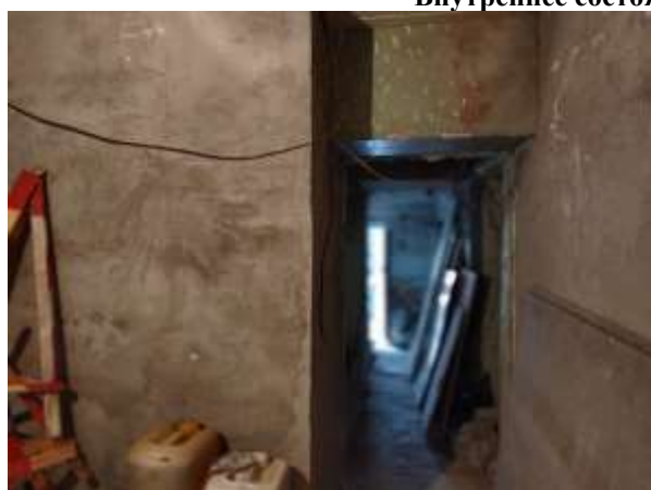
Фото 9. Вход в помещение
