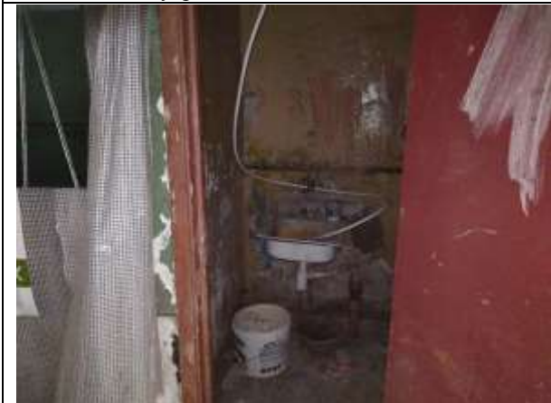
Фото 19. Внутреннее состояние Объекта оценки
