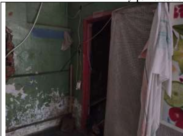
Фото 9. Внутреннее состояние Объекта оценки
