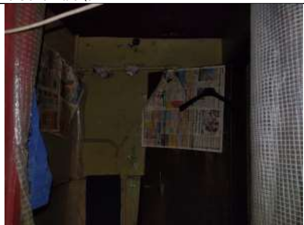
Фото 10. Внутреннее состояние Объекта оценки
