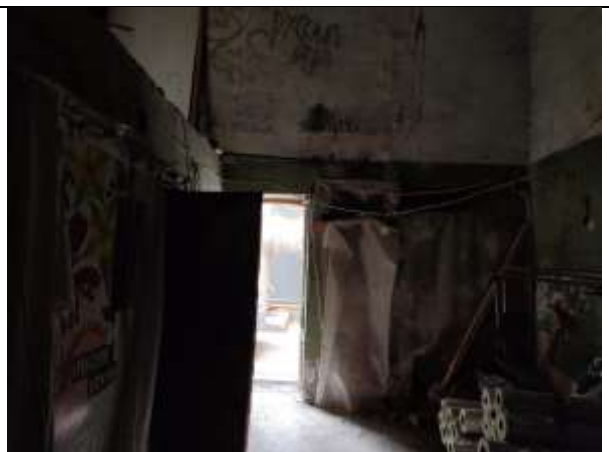
Фото 14. Внутреннее состояние Объекта оценки
