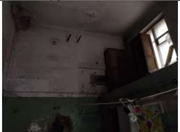
Фото 18. Внутреннее состояние Объекта оценки
