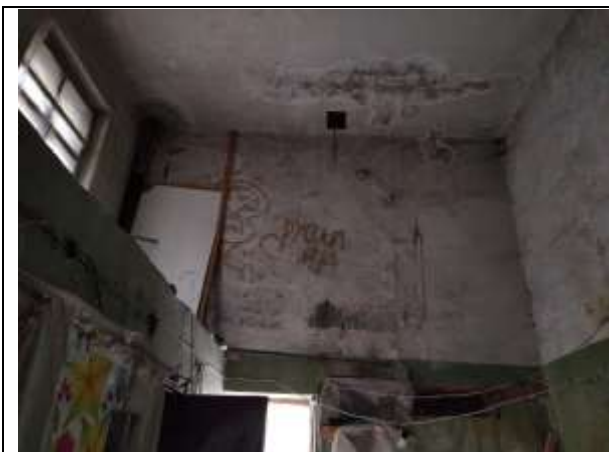
Фото 13. Внутреннее состояние Объекта оценки
