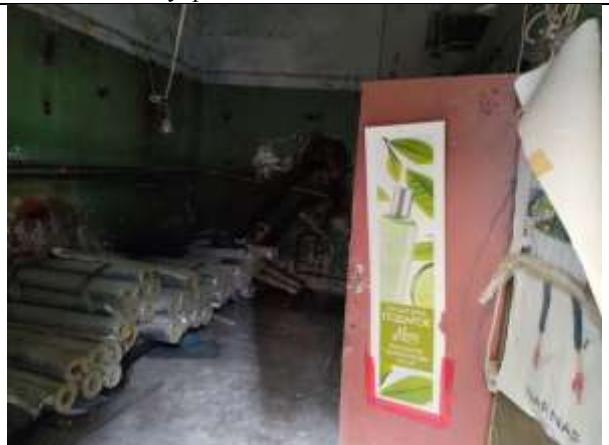
Фото 16. Внутреннее состояние Объекта оценки
