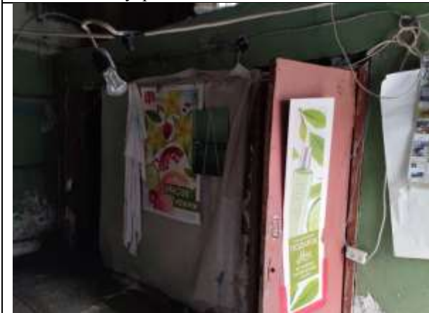
Фото 15. Внутреннее состояние Объекта оценки
