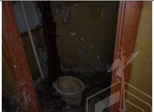
Фото 20. Внутреннее состояние Объекта оценки
