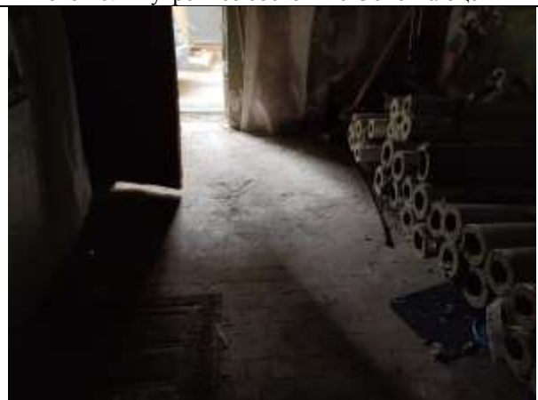
Фото 12. Внутреннее состояние Объекта оценки
