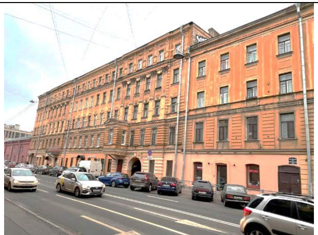
Фото 12. Вид здания расположения Объекта оценки
