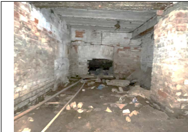
Фото 27. Типичное состояние Объекта оценки
