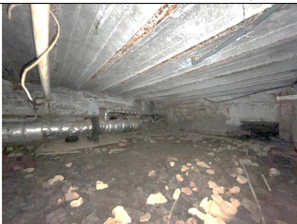
Фото 23. Типичное состояние Объекта оценки
