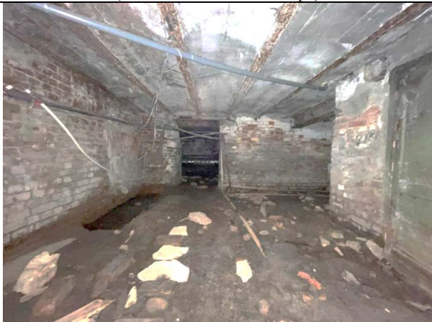
Фото 21. Типичное состояние Объекта оценки
