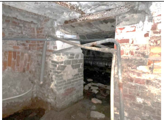
Фото 28. Типичное состояние Объекта оценки
