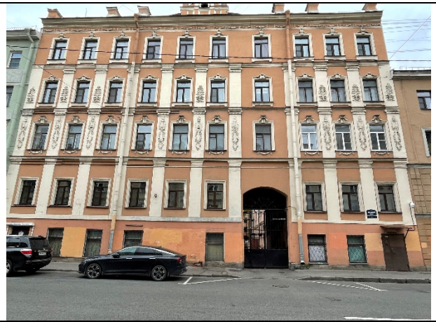
Фото 24. Вид здания расположения Объекта оценки
