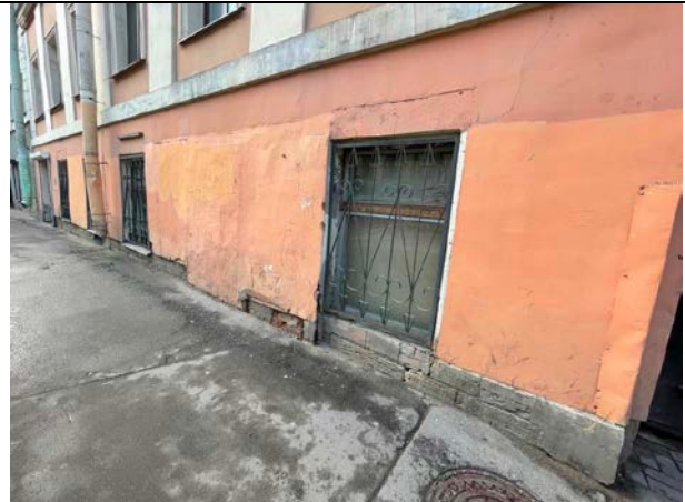
Фото 26. Вид окон Объекта оценки
