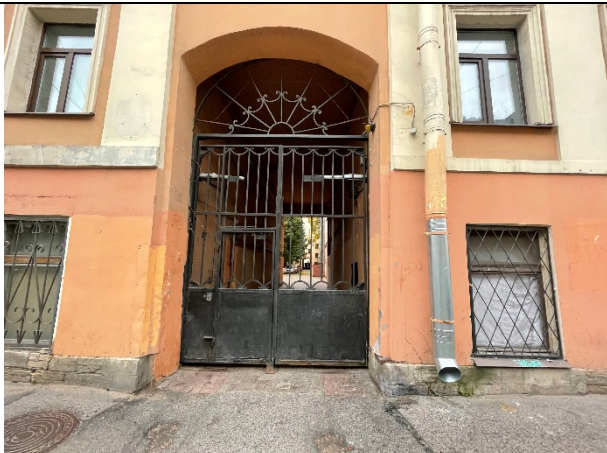
Фото 27. Проход через арку на внутреннюю территорию здания расположения Объекта оценки
