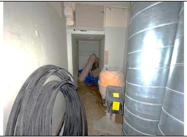
Фото 40. Типичное состояние Объекта оценки
