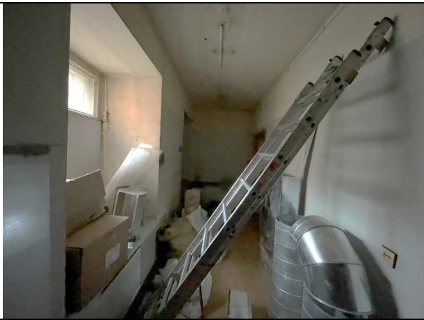
Фото 47. Типичное состояние Объекта оценки
