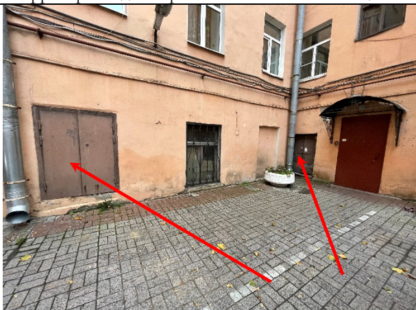
Фото 29. Два отдельных входа со двора Объекта оценки
