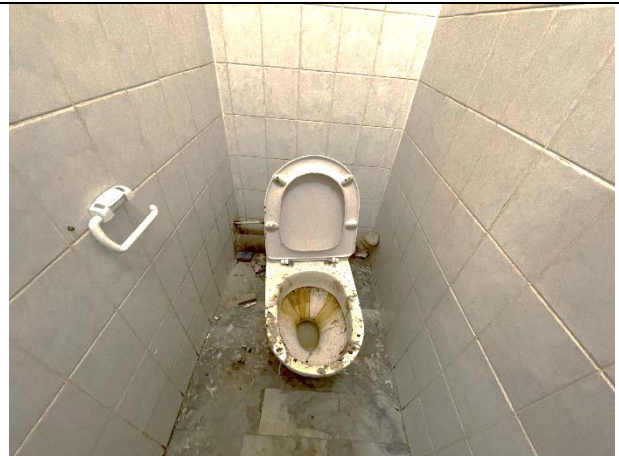
Фото 58. Типичное состояние Объекта оценки
