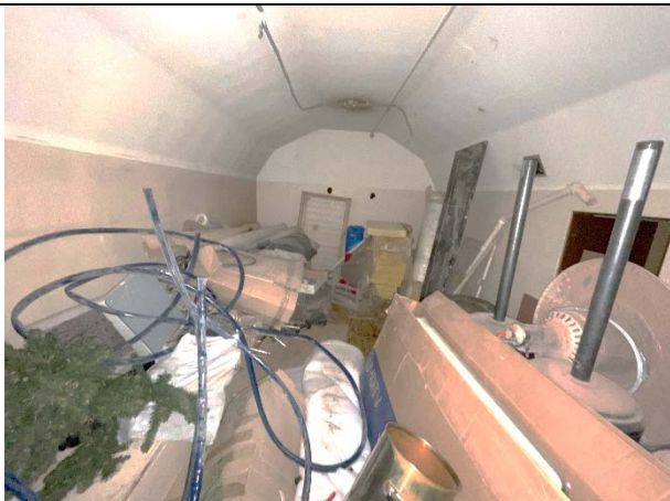
Фото 51. Типичное состояние Объекта оценки
