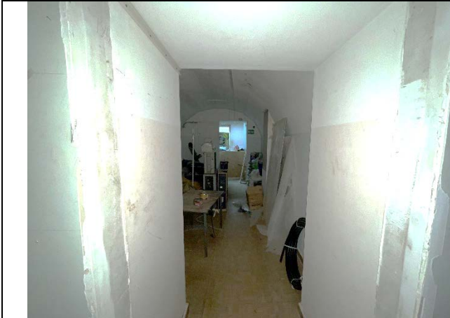
Фото 41. Типичное состояние Объекта оценки
